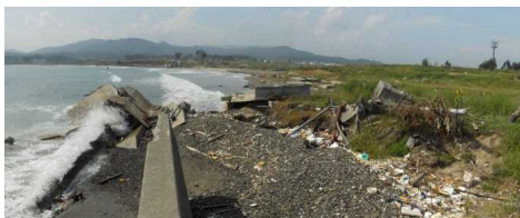
既設の防潮護岸工は流出・倒壊し、海岸防災林も壊滅状態
