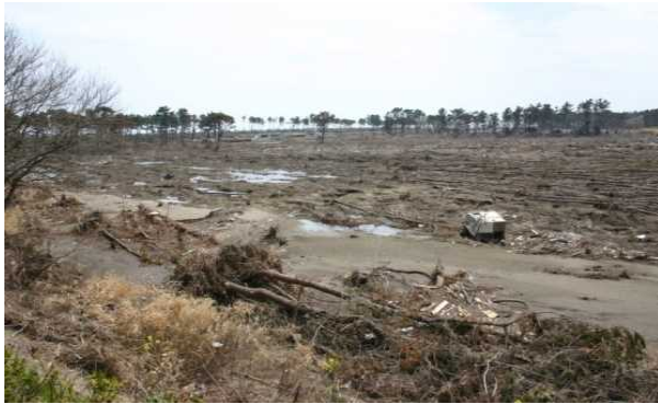
被災した海岸防災林
