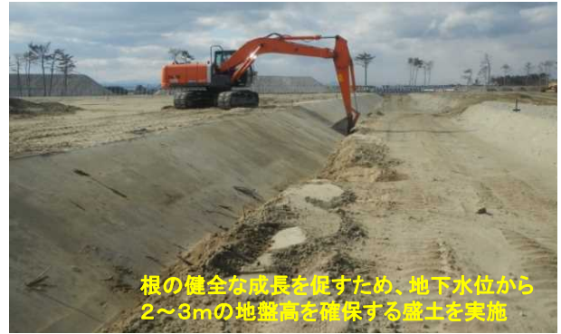
生育基盤盛土造成
