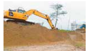
仙台市若林区荒浜国有林の海岸防災林復旧工事
