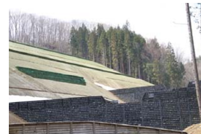
ニゴリ沢第一工区 [地すべり防止工事]
