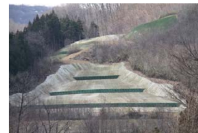
ニゴリ沢第二工区 [地すべり防止工事]
