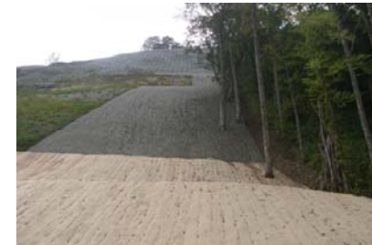
真湯(真湯キャンプ場) [山腹工]
