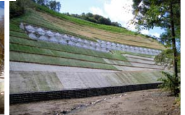
ニゴリ沢第二工区 【地すべり防止工事】
