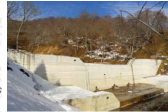
産女川【溪間工(谷止工)】
