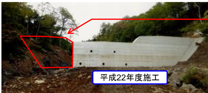
谷止工上流部堆積土砂の様子
