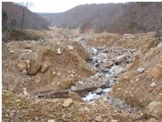
谷止工上流部堆積土砂の様子
