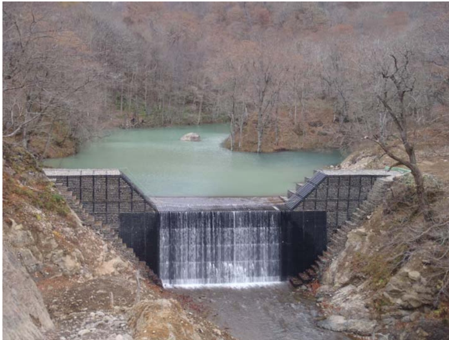
鋼製枠谷止工が完成しました
