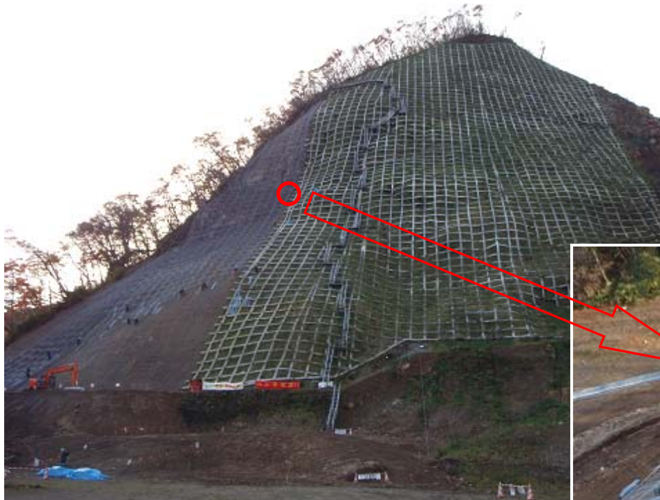
現場吹付砕工の鉄筋を組み立てています
