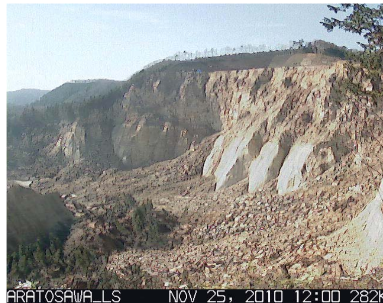
ARATOSAWA_LS NOV 25, 2010 12:00 282K 荒砥沢地すべりの監視カメラ画像(平成22年11月25日)
