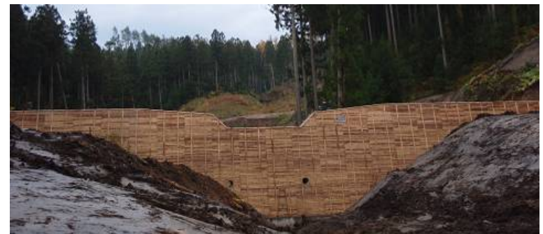
コンクリート谷止工を作っています 表面は間伐材を利用した残存型枠です
