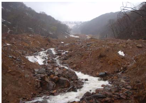
谷止工上流部 堆積土砂の様子
