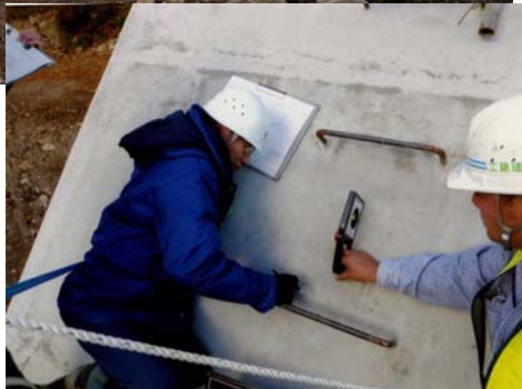
完成検査の様子 平成22年10月29日撮影
