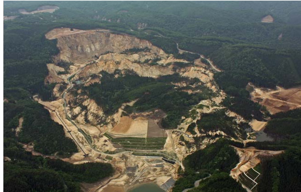
荒砥沢地区 (平成22年6月8日)
