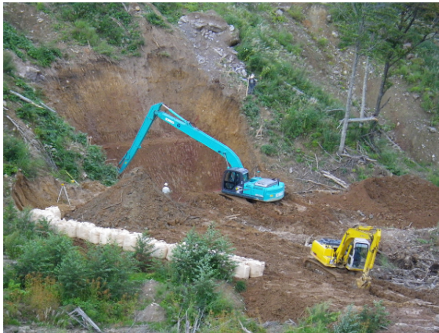
鋼製枠谷止工の床堀を行っています
