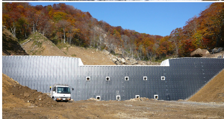
INSEM鋼製谷止工 平成21年10月完成
