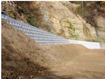
9号工事状況(平成21年10月21日)
