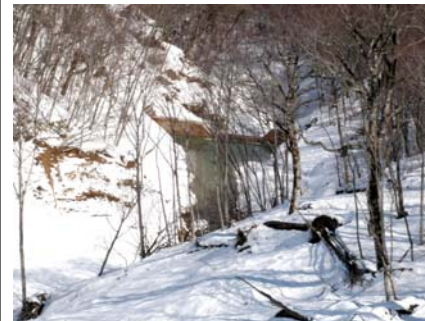
谷止工完成(平成22年3月5日)
