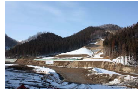
谷止工完成(平成22年2月25日)
