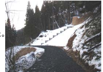
完成(平成21年12月24日)
