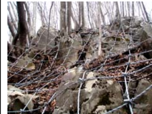
ロープ伏工完成(平成22年3月4日)
