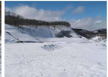
吹付砕工ほか完成(平成22年3月5日)
