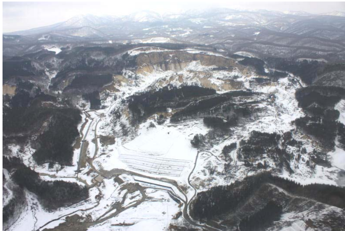
荒砥沢地区 (平成22年3月12日)
