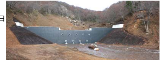
谷止工 完成(平成21年11月4日)
