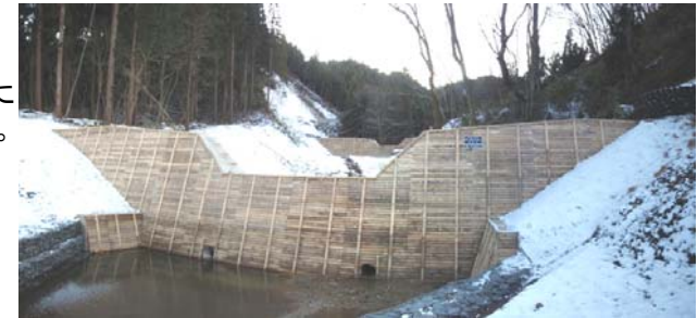
谷止工完成 (平成21年12月17日)
