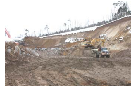
排土工施工状況(平成22年2月17日)
