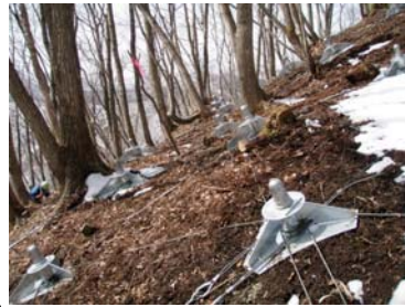
地山補強土工完成 (平成22年3月15日)
