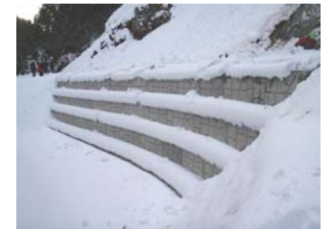
完成(平成21年12月24日)
