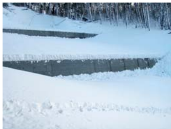
土留工完成 (平成22年1月7日)
