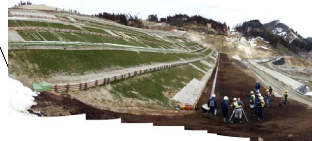
鋼管杭打工等完成(平成22年3月9日)
