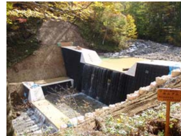
谷止工 工事状況(平成21年10月15日)
