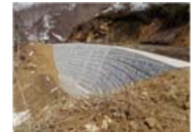
コンクリートブロック擁壁完了
