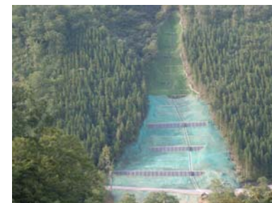
山腹工. 完成状況(平成21年10月27日)
