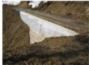
二段式擁壁完了
