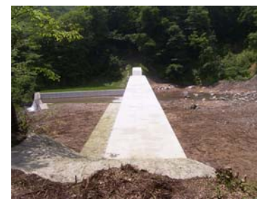
コンクリート谷止工 (平成21年7月15日)
