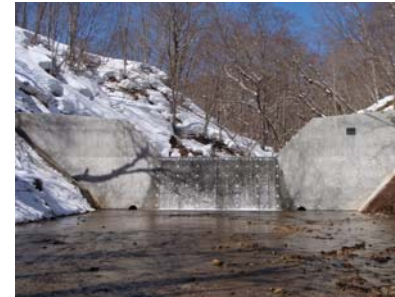
コンクリート谷止工 完成(平22年3月10日)
