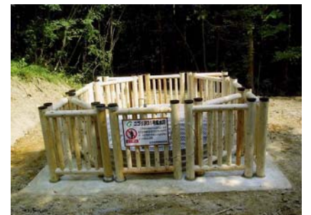
集水井完成状況(平成21年7月27日)
