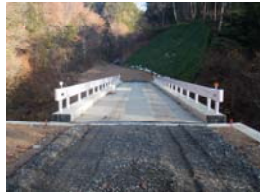
渋民3-2号、橋梁工2完成 (平成21年11月6日)
