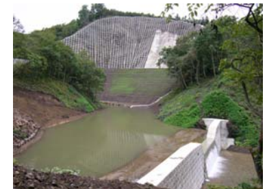
山腹工 工事完成(平成21年8月31日)
