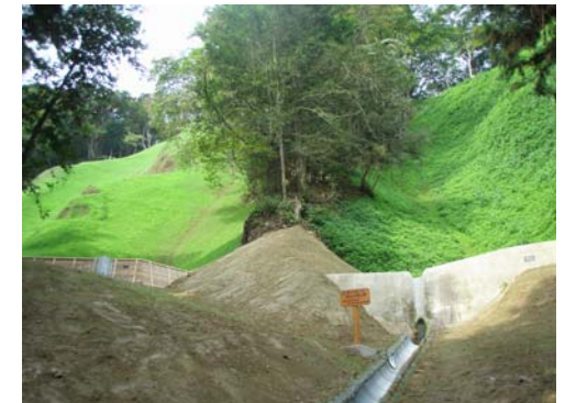
山腹工 工事状況 (平成21年9月18日)
