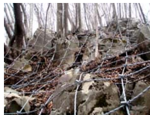
ロープ伏工完成(平成22年3月4日)
