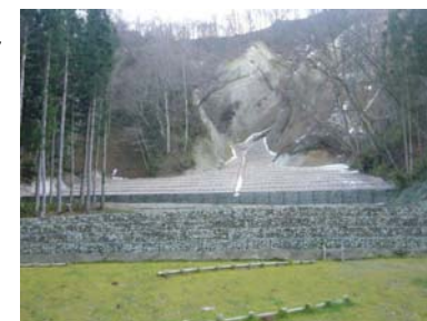
土留工ほか 完成 (平成21年12月10日)
