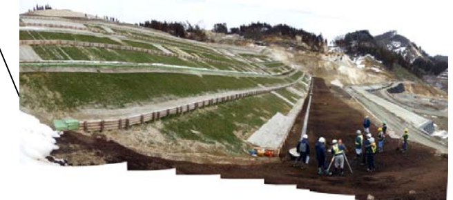
鋼管杭打工等完成(平成22年3月9日)
