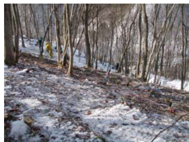
地山補強土工施工状況 (平成22年1月22日)
