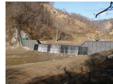
床固工完成(平成21年11月24日)
