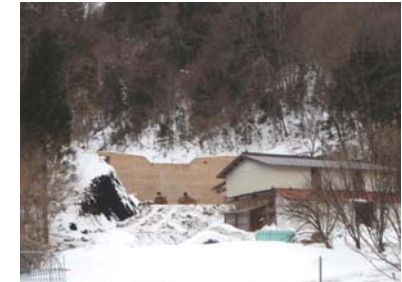
谷止工施工完成 (平成22年2月15日)
