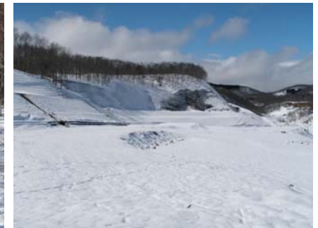
吹付砕工ほか完成(平成22年3月5日)
