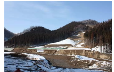
谷止工完成(平成22年2月25日)
