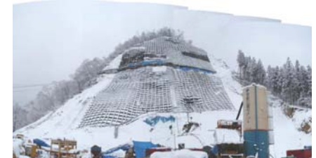
吹付砕工施工状況(平成22年3月2日)
