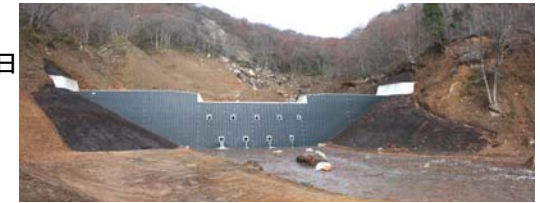
谷止工 完成(平成21年11月4日)
