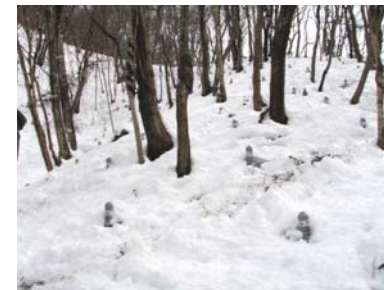
地山補強土工完成(平成22年3月11日)
