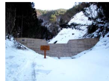
谷止工完成(平成22年2月2日)
