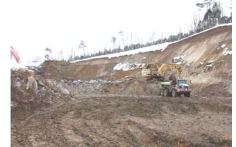
排土工施工状況(平成22年2月17日)
