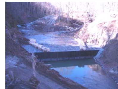
谷止工終了状況(平成21年12月7日)
