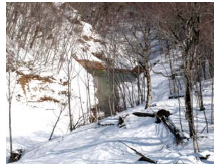
谷止工完成(平成22年3月5日)
