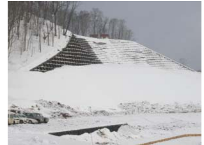
吹付砕工施工完成(平成22年2月19日)
