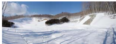
山腹工完成(平成22年1月29日)
