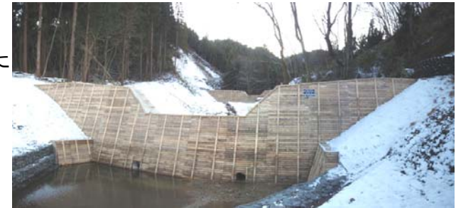
谷止工完成 (平成21年12月17日)
