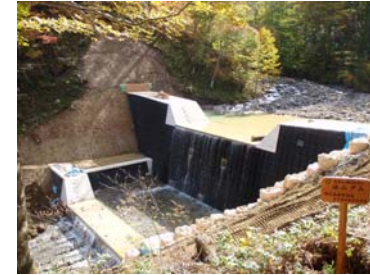
谷止工 工事状況(平成21年10月15日)
