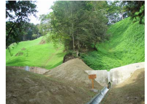
山腹工 工事状況 (平成21年9月18日)
