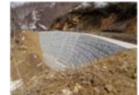
コンクリートブロック擁壁完了
