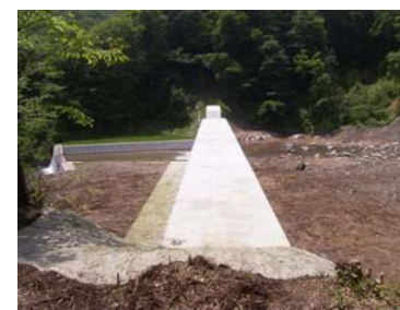
コンクリート谷止工 (平成21年7月15日)
