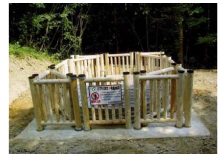
集水井完成状況(平成21年7月27日)
