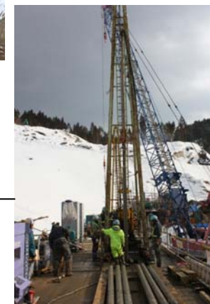
杭打工施工状況(平成22年1月20日)
