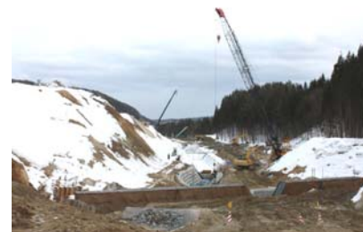
ブロック水路工施工状況(平成22年2月17日)
