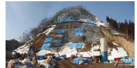
吹付砕工施工状況(平成22年2月25日)
