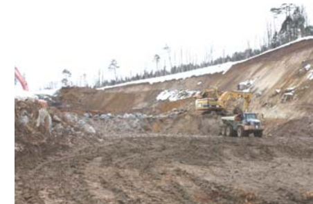
排土工施工状況(平成22年2月17日)
