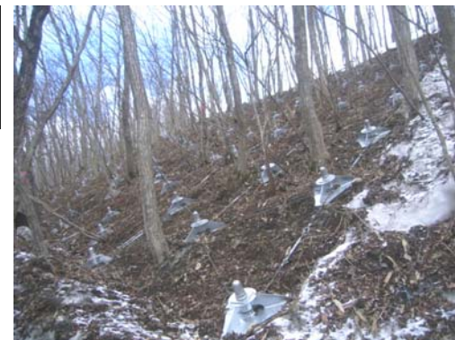
地山補強土工施工状況 (平成22年1月27日)
