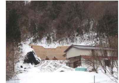
谷止工施工完成 (平成22年2月15日)
