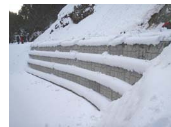
完成(平成21年12月24日)
