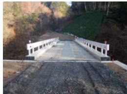
渋民3-2号、橋梁工2完成 (平成21年11月6日)
