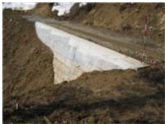
二段式擁壁完了
