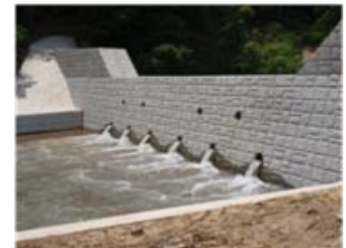
コンクリート谷止工 工事状況 (平成21年6月5日)
