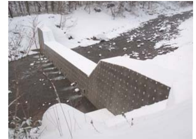
コンクリート谷止工 工事完成(平成22年1月28日)
