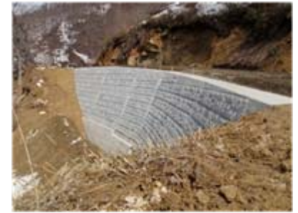
コンクリートブロック擁壁完了
