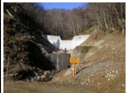
コンクリート谷止工完成 (平成21年12月8日)
