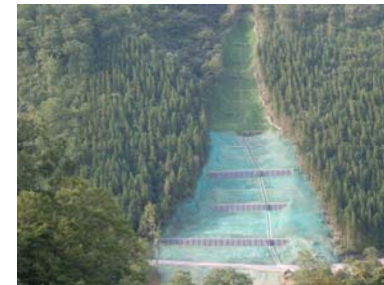
山腹工. 完成状況(平成21年10月27日)
