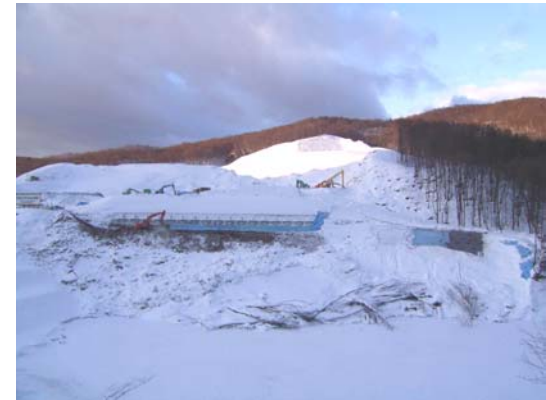
施工状況(平成22年1月28日)
