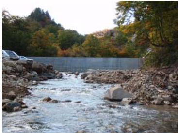
谷止工 工事状況 (平成21年10月15日)
