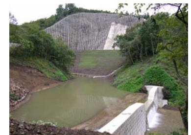
山腹工 工事完成(平成21年8月31日)
