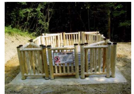
集水井完成状況(平成21年7月27日)
