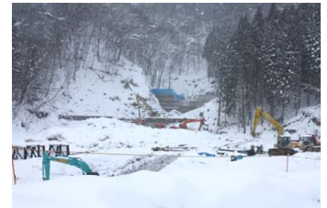
谷止工施工状況(平成22年1月14日)
