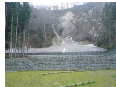
土留工ほか 完成 (平成21年12月10日)
