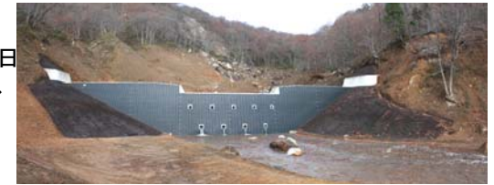
谷止工 完成(平成21年11月4日)
