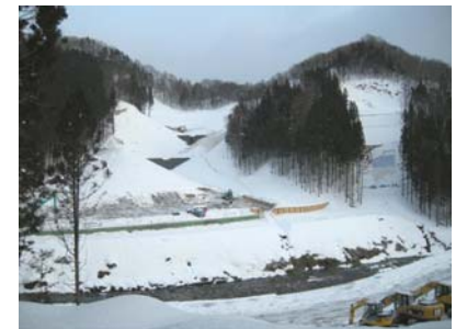
山腹工施工状況(平成21年12月16日)
