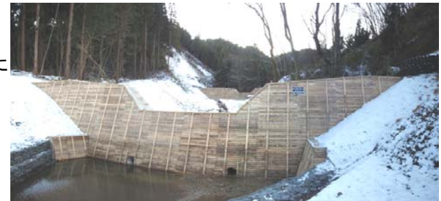
谷止工完成 (平成21年12月17日)
