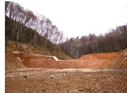
谷止工施工状況(平成21年11月17日)
