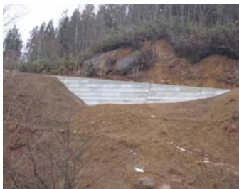
11号工事状況(平成21年12月11日)
