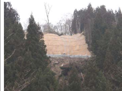
4号工事状況 (平成21年12月11日)
