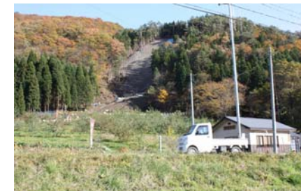
山腹工施工状況(平成21年11月6日)
