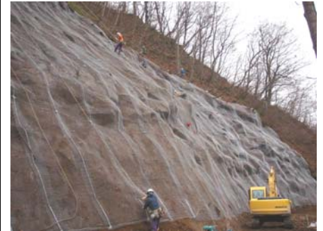
1号工事状況 (平成21年12月11日)
