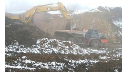
排土工施工状況(平成22年1月12日)
