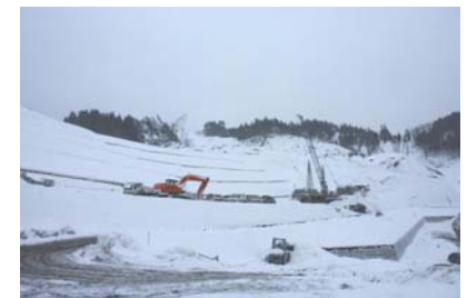
杭打工施工状況(平成22年1月14日)
