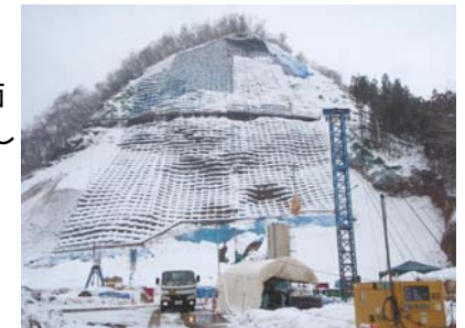
吹付砕工施工状況(平成22年1月12日)
