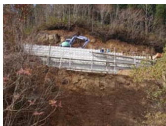
11号工事状況(平成21年11月2日)
