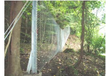
落石防護柵の設置(平成21年8月28日)
