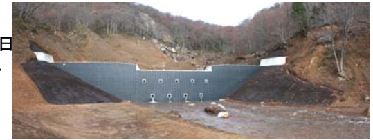
谷止工 完成(平成21年11月4日)
