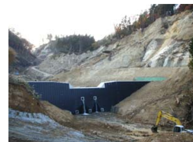
谷止工施工状況(平成21年10月23日)
