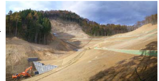
山腹工施工状況(平成21年11月4日)
