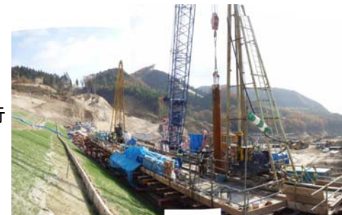
杭打工施工状況(平成21年10月28日)
