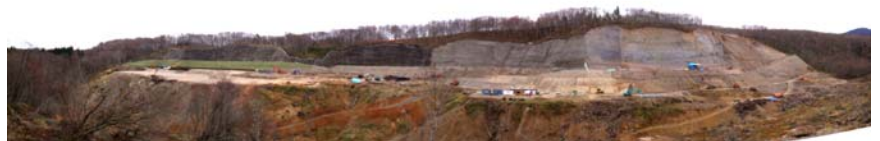
施工地の全景 (平成21年11月17日)
