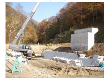
左岸護岸工設置状況 (平成21年10月30日)
