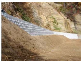
9号工事状況(平成21年10月21日)
