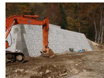
右岸護岸工設置状況 (平成21年10月30日)
