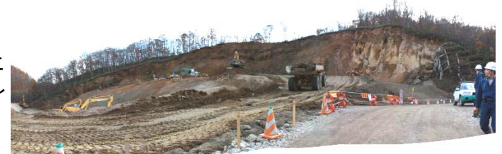
切土工施工状況 (平成21年11月4日)
