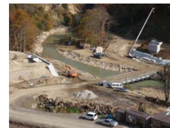
工事状況全景(平成21年10月30日)
