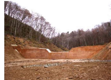
谷止工施工状況 (平成21年11月17日)
