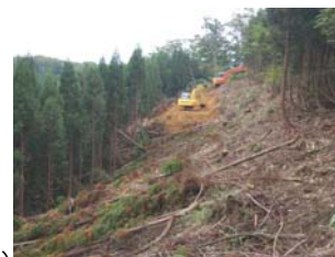
ヒアヒクラ沢林道 災害復旧工事状況 (平成21年9月29日)
