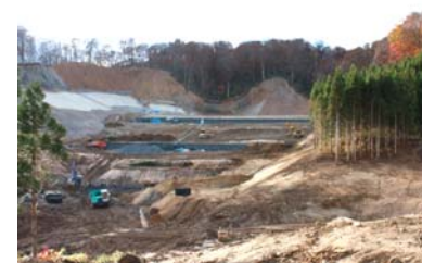
山腹工施工状況(平成21年11月4日)
