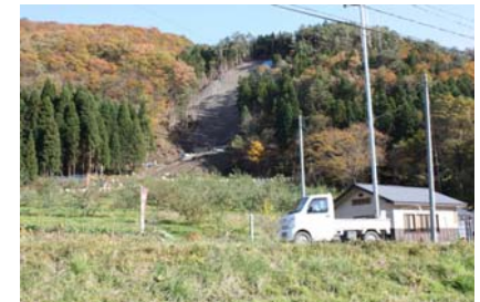
山腹工施工状況(平成21年11月6日)
