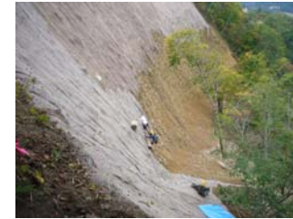
上部法面伏工施工状況 (平成21年10月1日)
