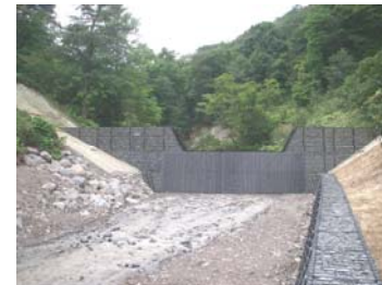
鋼製枠谷止工 工事完成(平成21年9月15日)
