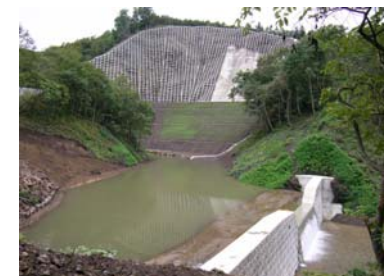
山腹工 工事完成(平成21年8月31日)
