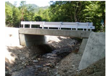
橋梁付替(平成21年6月25日)
