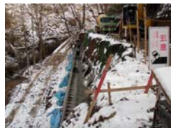
1号ブロック積工 (平成21年11月19日)
