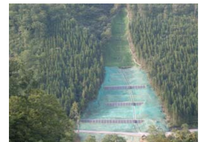
山腹工. 完成状況(平成21年10月27日)
