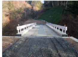
渋民3-2号、橋梁工2完成 (平成21年11月6日)
