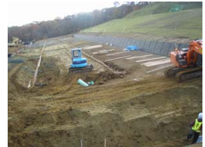
施工状況(平成21年11月5日)
