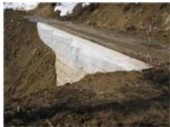
二段式擁壁完了
