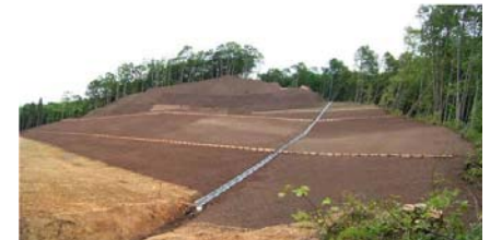
排土工工事状況(平成21年6月18日)
