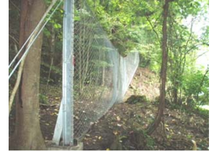
落石防護柵の設置(平成21年8月28日)
