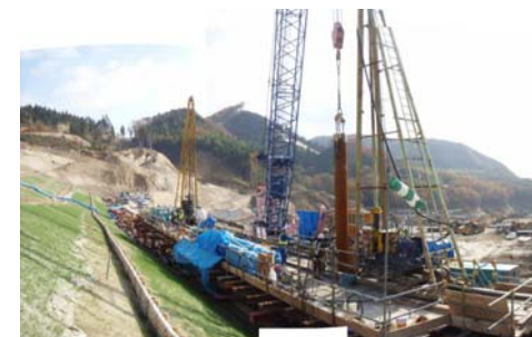
杭打工施工状況(平成21年10月28日)
