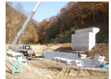
左岸護岸工設置状況 (平成21年10月30日)
