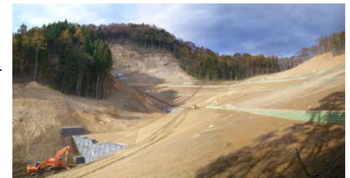
山腹工施工状況(平成21年11月4日)
