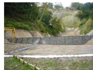
鋼製土留工施工状況 (平成21年10月1日)
