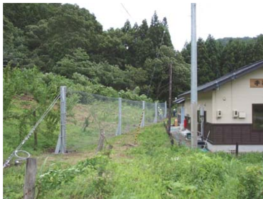
落石防護柵の設置(平成21年7月13日)
