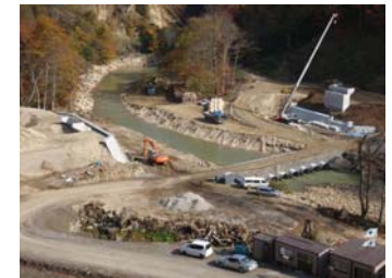
工事状況全景(平成21年10月30日)
