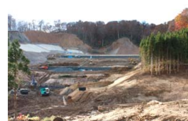
山腹工、土留工施工状況(平成21年11月4日)
