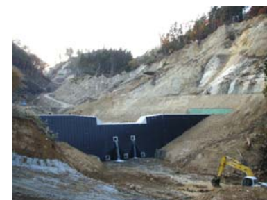
鋼製谷止工施工状況(平成21年10月23日)
