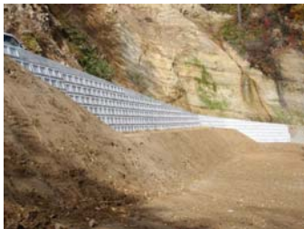
9号工事状況(平成21年10月21日)
