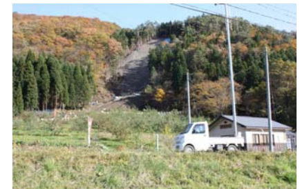
山腹工施工状況(平成21年11月6日)
