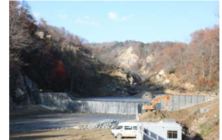
鋼製枠床固工施工状況(平成21年11月6日)
