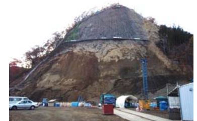
法砕工施工状況(平成21年11月4日)
