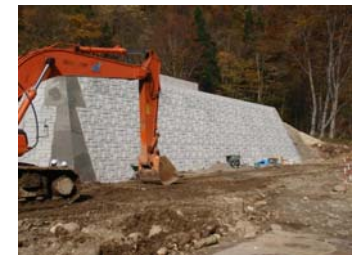
右岸護岸工設置状況 (平成21年10月30日)
