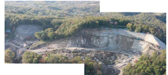
施工地の全景 (平成21年10月14日)
