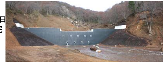
鋼製谷止工 完成(平成21年11月4日)
