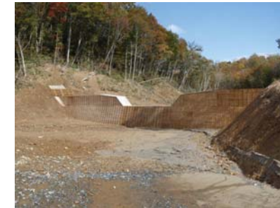
谷止工施工状況 (平成21年10月20日)
