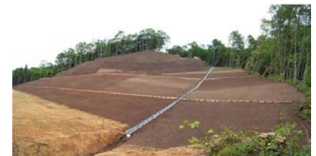
排土工工事状況(平成21年6月18日)
