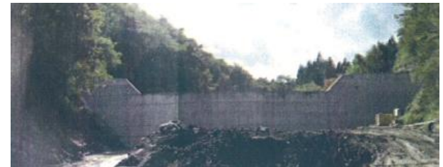
谷止工 工事完成(平成21年10月27日)
