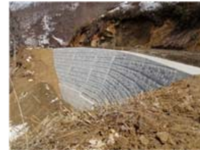
コンクリートブロック擁壁完了
