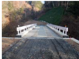
渋民3-2号、橋梁工2完成 (平成21年11月6日)
