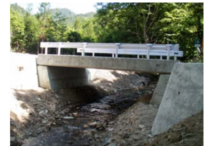
橋梁付替(平成21年6月25日)
