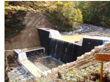
谷止工 工事状況(平成21年10月15日)
