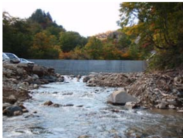
谷止工 工事状況 (平成21年10月15日)
