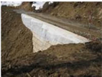
二段式擁壁完了
