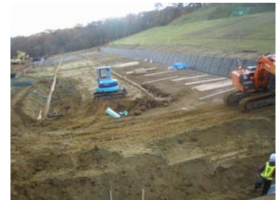
施工状況(平成21年11月5日)
