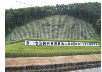
吹付砕工 (完成:平成21年8月4日)
