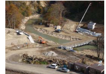
工事状況全景(平成21年10月30日)
