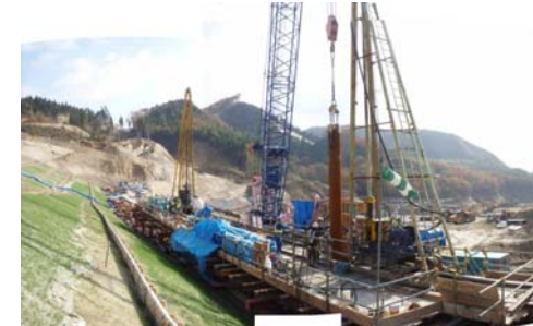
杭打工施工状況(平成21年10月28日)
