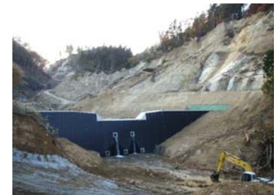
鋼製谷止工施工状況(平成21年10月23日)
