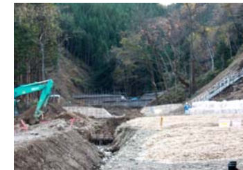
谷止工 工事状況 (平成21年11月4日)
