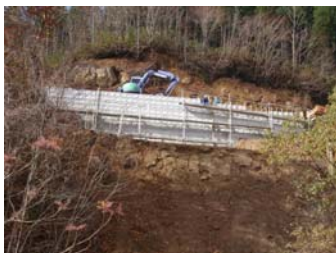
11号工事状況(平成21年11月2日)
