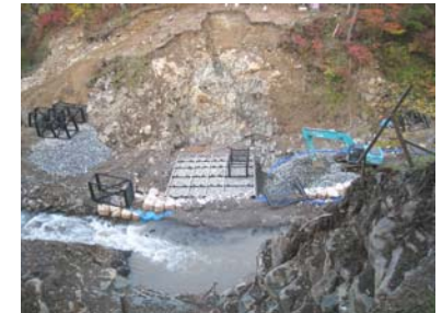
谷止工施工状況(平成21年10月22日)
