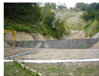
鋼製土留工施工状況 (平成21年10月1日)
