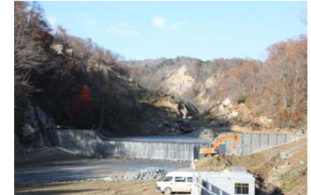
鋼製枠床固工施工状況(平成21年11月6日)
