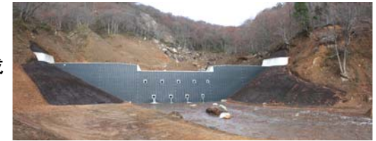
鋼製谷止工 完成(平成21年11月4日)
