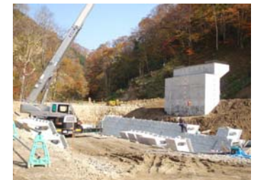
左岸護岸工設置状況 (平成21年10月30日)
