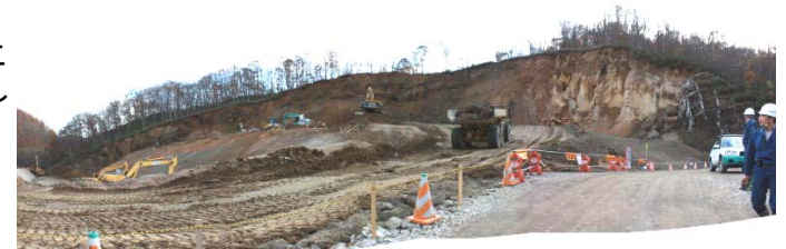
法切工施工状況(平成21年11月4日)
