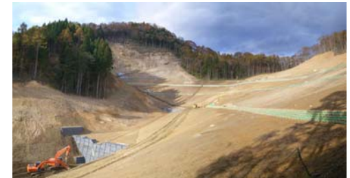
山腹工施工状況(平成21年11月4日)
