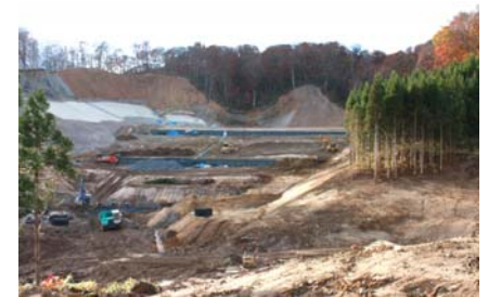
山腹工、土留工施工状況 (平成21年11月4日)
