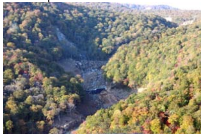
ドゾウ沢上流部の荒廃状況 (平成21年10月14日)
