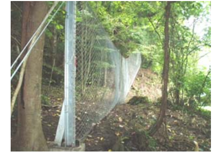
落石防護柵の設置(平成21年8月28日)
