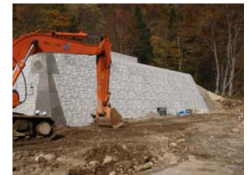
右岸護岸工設置状況 (平成21年10月30日)
