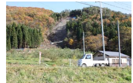
山腹工施工状況(平成21年11月6日)
