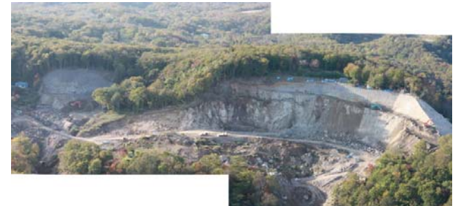
施工地の全景(平成21年10月14日)
