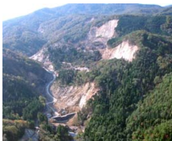
シヅミクラ沢上流部の荒廃状況 (平成21年10月14日)
