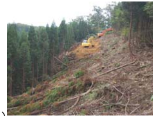
ヒアヒクラ沢林道 災害復旧工事状況 (平成21年9月29日)
