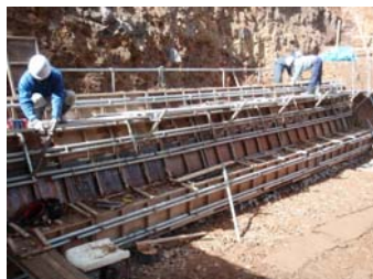
11号施工状況(平成21年10月21日)
