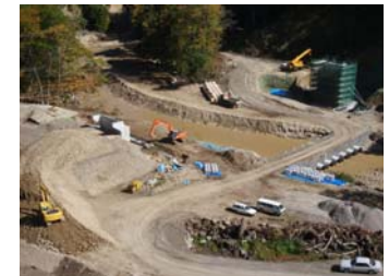
工事状況全景(平成21年10月15日)
