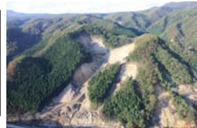
施工箇所全景(平成21年10月14日)
