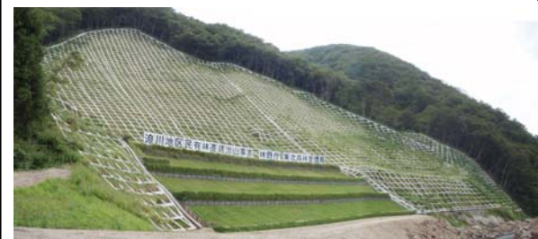
吹付枠工(完成:平成21年9月18日撮影)
