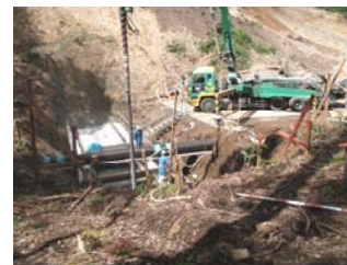
谷止工 工事状況 (平成21年9月14日)
