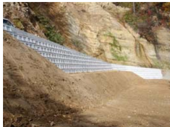
9号工事状況(平成21年10月21日)
