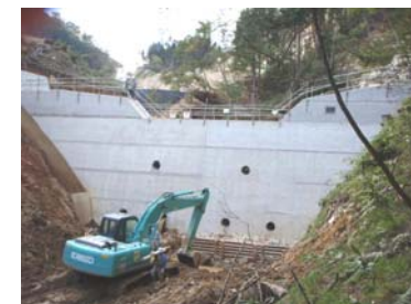
2号谷止工施工状況(平成21年10月1日)
