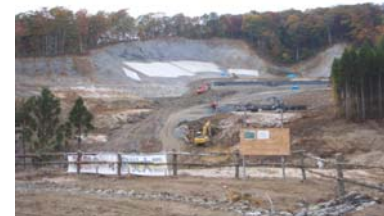
右岸山腹工、土留工施工状況(平成21年10月19日)
