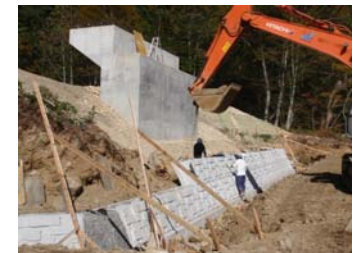
岸側護岸工工事状況 (平成21年10月15日)
