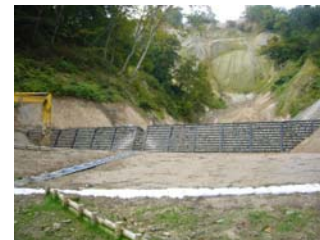
鋼製土留工施工状況 (平成21年10月1日)
