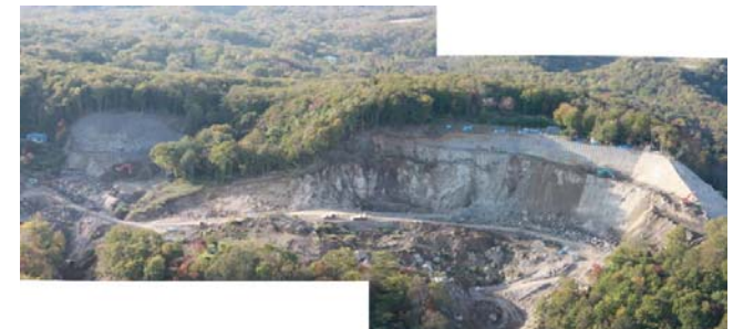
施工状況(平成21年10月14日)
