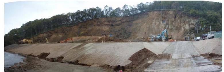
法切工施工状況(平成21年10月9日)
