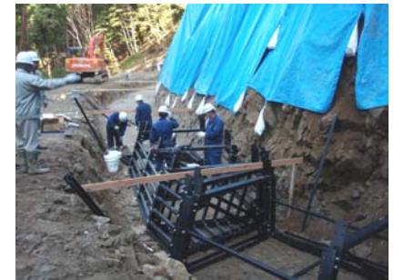
鋼製枠土留工施工状況(平成21年10月16日)
