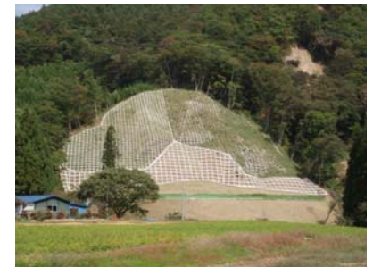
法砕工 完成(平成21年10月13日)
