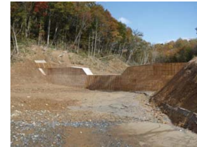
谷止工(平成21年10月20日)
