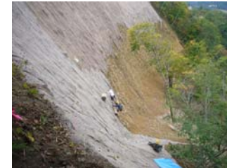
上部法面伏工施工状況 (平成21年10月1日)
