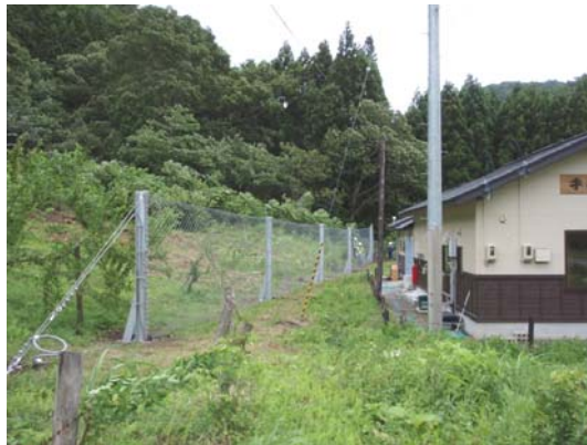
落石防護柵の設置
