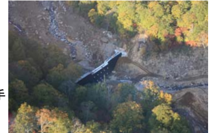
鋼製谷止工の施工状況(平成21年10月14日)
