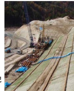
杭打工施工状況 (平成21年10月22日)
