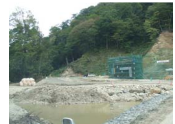
トラス橋左岸橋台状況 (平成21年10月15日)
