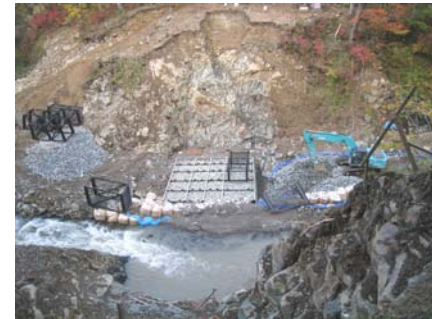
谷止工施工状況(平成21年10月22日)
