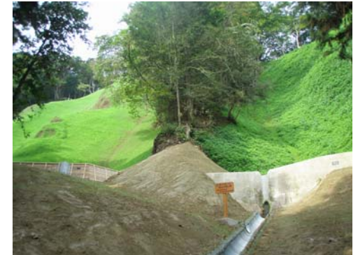
山腹工 工事状況 (平成21年9月18日)
