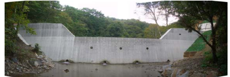
コンクリート谷止工 工事完成(平成21年9月15日)
