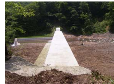
コンクリート谷止工 (平成21年7月15日)
