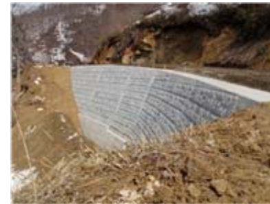
コンクリートブロック擁壁完了
