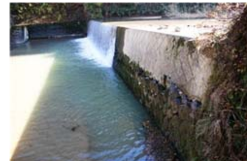
産女川治山ダム 施設被害状況
