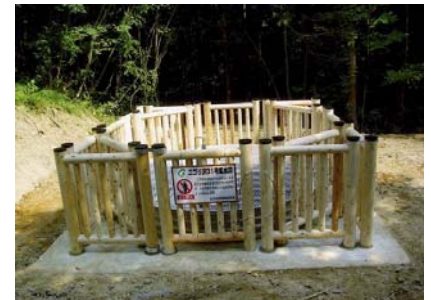
集水井完成状況(平成21年7月27日)
