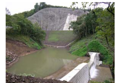
山腹工 工事完成(平成21年8月31日)
