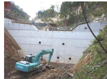
2号谷止工施工状況(平成21年10月1日)
