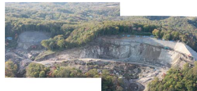
施工状況(平成21年10月14日)
