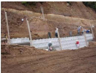
10号施工状況(平成21年10月13日)
