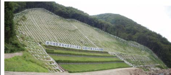
吹付枠工(完成:平成21年9月18日撮影)
