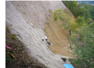
上部法面伏工施工状況 (平成21年10月1日)
