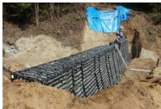
鋼製自在枠谷止工施工状況 (平成21年9月25日)
