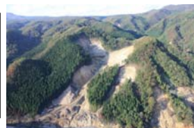
施工箇所全景(平成21年10月14日)
