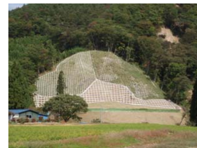
法砕工 完成(平成21年10月13日)
