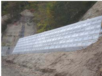
8号施工状況(平成21年10月13日)
