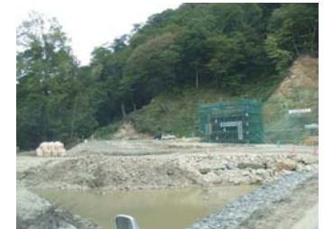
トラス橋左岸橋台状況 (平成21年10月15日)
