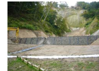
鋼製土留工施工状況 (平成21年10月1日)
