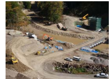
工事状況全景(平成21年10月15日)
