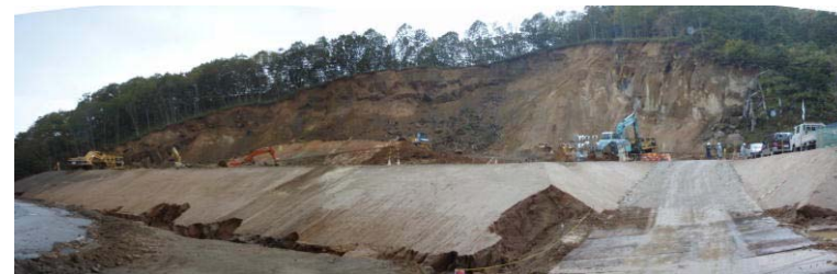
法切工施工状況(平成21年10月9日)
