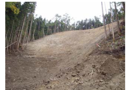
法切工施工状況(平成21年10月5日)
