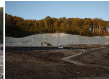
左岸山腹工 法切工完了 (平成21年10月14日)
