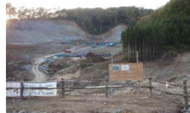
右岸山腹工 土留工施工状況 (平成21年10月14日)
