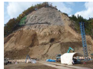
ラス張り施工状況(平成21年10月14日)
