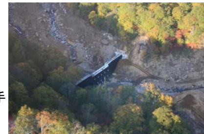
鋼製谷止工の施工状況(平成21年10月14日)
