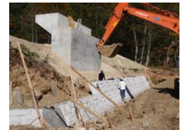
岸側護岸工工事状況 (平成21年10月15日)
