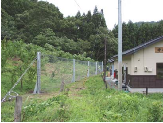
落石防護柵の設置
