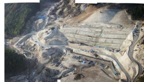
施工状況(平成21年10月14日)
