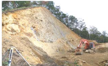
最上部切土工状況(平成21年10月6日)
