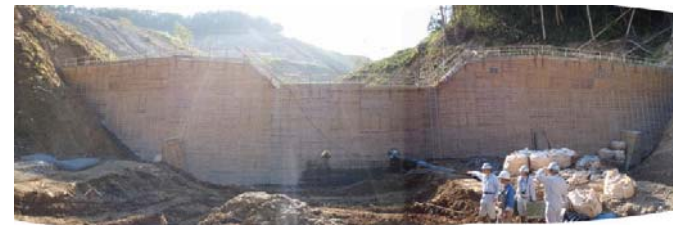
谷止工施工状況(平成21年9月16日)
