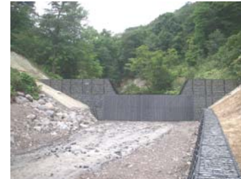
鋼製枠谷止工 工事完成(平成21年9月15日)
