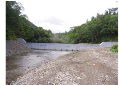
コンクリート谷止工 完成状況(平成21年8月31日)
