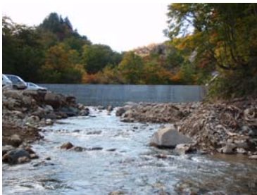
谷止工 工事状況 (平成21年10月15日)
