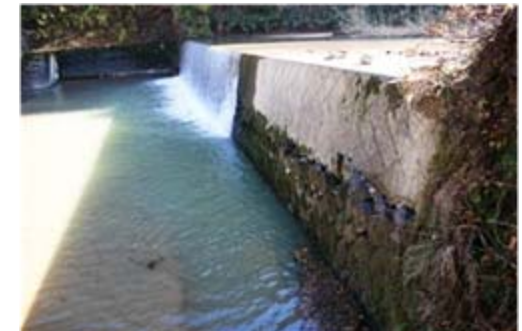
産女川治山ダム 施設被害状況
