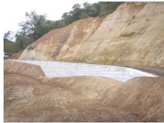
(3～11号)7号工事状況 (平成21年9月29日)
