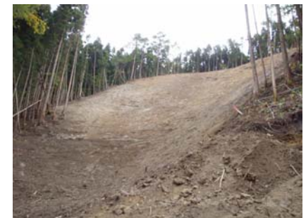
法切工施工状況(平成21年10月5日)
