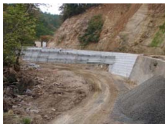
9号工事状況(平成21年10月7日)
