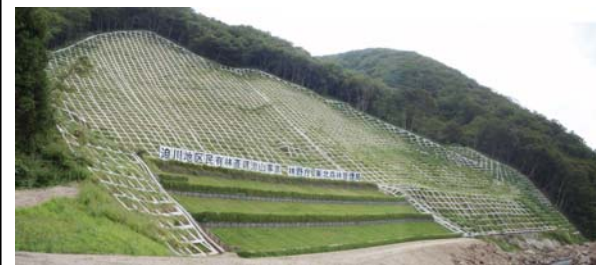
吹付枠工(完成:平成21年9月18日撮影)
