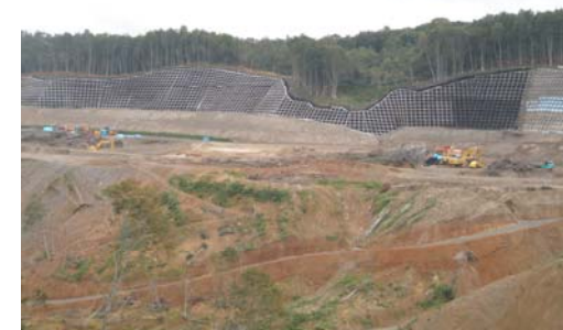
工事状況(平成21年9月15日)
