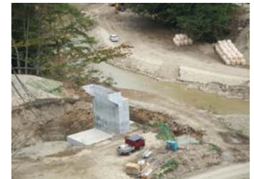
トラス橋右岸橋台コンクリート打設状況 (平成21年10月6日)
