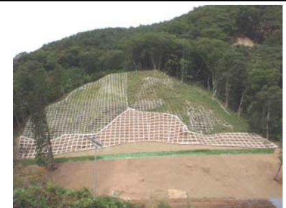
法砕工施工状況(平成21年9月30日)
