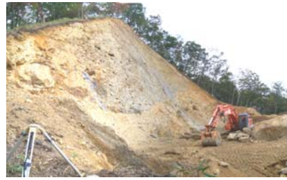
最上部切土工施工状況(平成21年10月6日)
