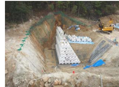
ブロック谷止工施工状況(平成21年10月1日)
