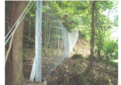
落石防護柵の設置(平成21年8月28日)
