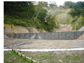
鋼製土留工施工状況 (平成21年10月1日)
