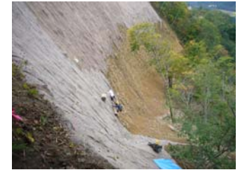
上部法面伏工施工状況 (平成21年10月1日)
