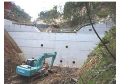
2号谷止工施工状況(平成21年10月1日)
