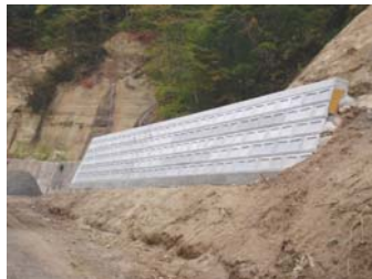
8号工事状況(平成21年10月7日)
