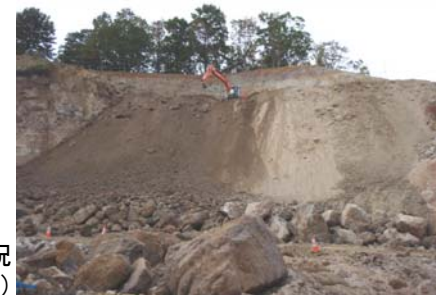
法切工施工状況 (平成21年10月6日)
