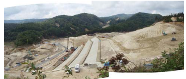
施工状況(平成21年10月1日)
