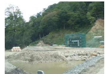
トラス橋左岸橋台コンクリート打設状況 (平成21年10月6日)
