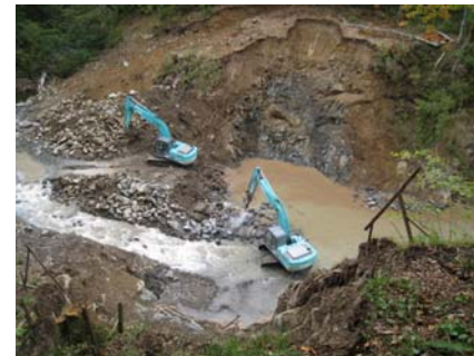
谷止工掘削状況(平成21年9月30日)
