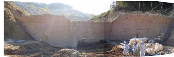
谷止工施工状況(平成21年9月16日)
