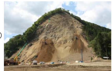
法切工施工状況(平成21年9月15日)
