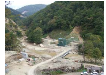
工事状況全景(平成21年10月6日)
