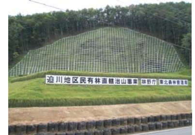
吹付砕工 (完成:平成21年8月4日)
