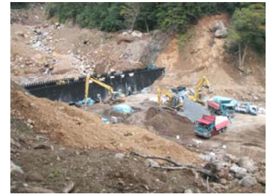
鋼製谷止工の施工状況(平成21年9月1日)
