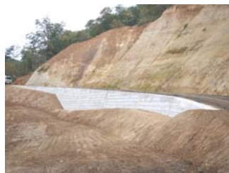
(3～11号)7号工事状況 (平成21年9月29日)
