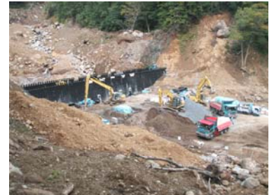
INSEM鋼製谷止工の施工状況(平成21年9月1日)
