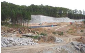
法切工・土留工施工状況 (平成21年9月30日)
