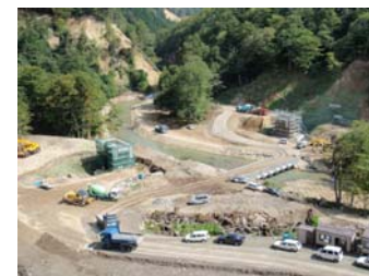
工事状況全景(平成21年9月25日)
