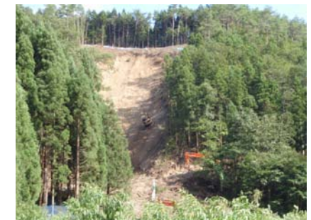
法切工施工状況(平成21年9月7日)
