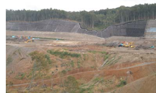
工事状況(平成21年9月15日)
