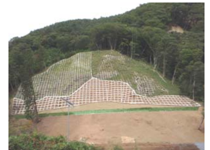
法砕工施工状況(平成21年9月30日)
