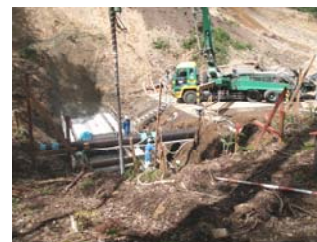
谷止工 工事状況 (平成21年9月14日)
