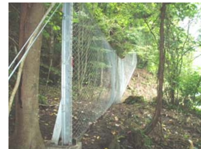
落石防護柵の設置(平成21年8月28日)
