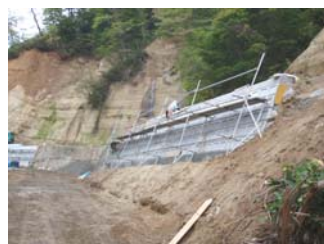
8号工事状況(平成21年9月29日)
