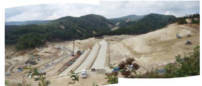
施工状況(平成21年10月1日)
