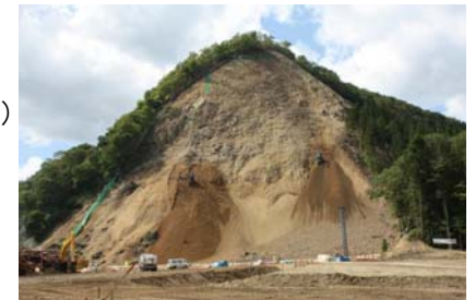
法切工施工状況(平成21年9月15日)
