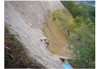
上部法面伏工施工状況 (平成21年10月1日)
