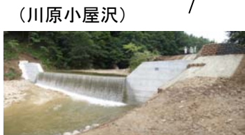
谷止工 (平成21年7月27日)
