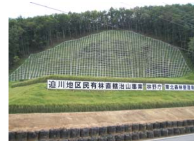
吹付砕工 (平成21年8月4日)
