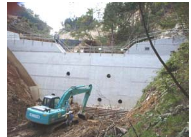
2号谷止工施工状況(平成21年10月1日)
