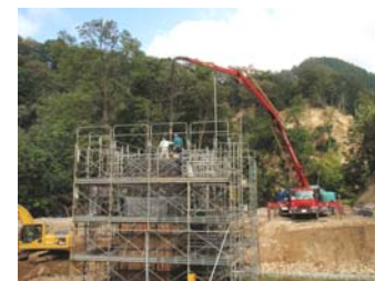
トラス橋左岸橋台鉄筋組立状況 (平成21年9月25日)
