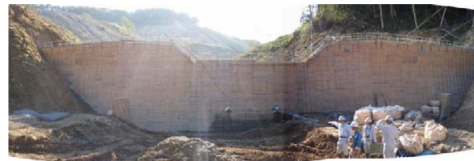
谷止工施工状況(平成21年9月16日)
