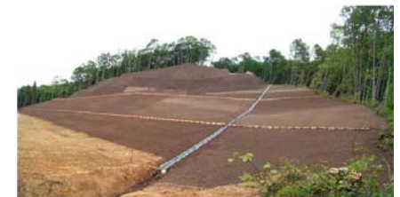
排土工工事状況(平成21年6月18日)
