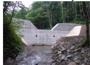
コンクリート谷止工 工事完成 (平成21年8月31日)
