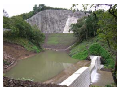
山腹工 工事完成(平成21年8月31日)
