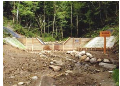
工事完成(平成21年8月11日)
