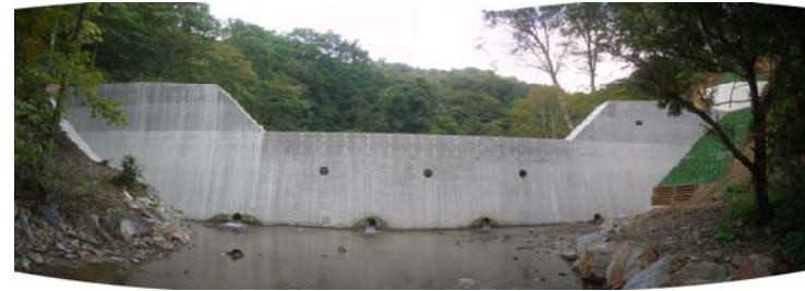
コンクリート谷止工 工事完成(平21年9月15日)
