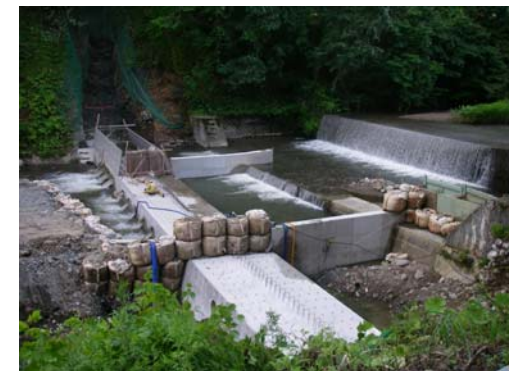
工事状況(平成21年7月15日)
