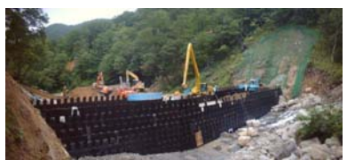
一ツ石沢 工事状況(平成21年8月2日)
