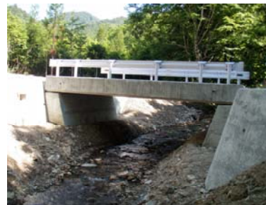
橋梁付替(平成21年6月25日)
