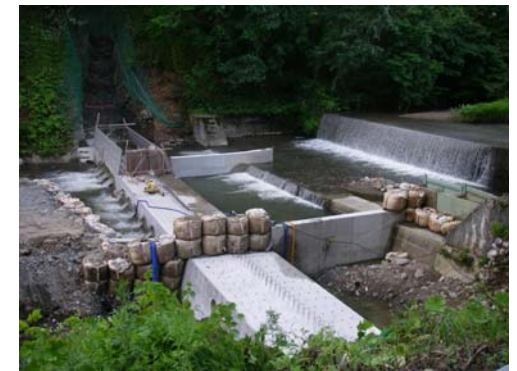
工事状況(平成21年7月15日)
