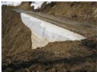
二段式擁壁完了
