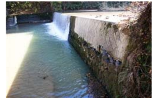
産女川治山ダム 施設被害状況
