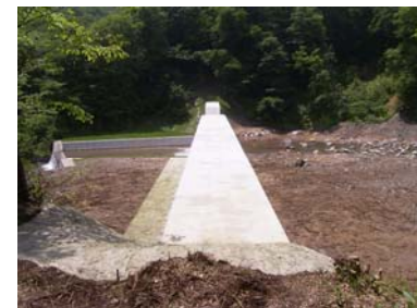
コンクリート谷止工 (平成21年7月15日)
