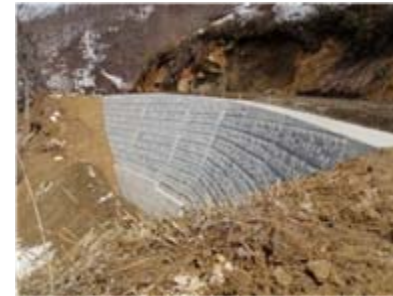
コンクリートブロック擁壁完了
