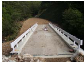
渋民3-2号、橋梁工 工事状況(平成21年9月14日)
