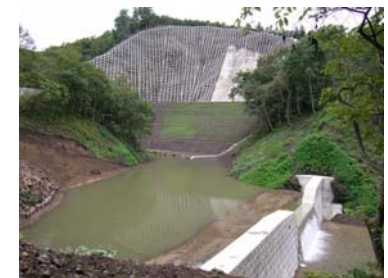
山腹工 工事完成(平成21年8月31日)
