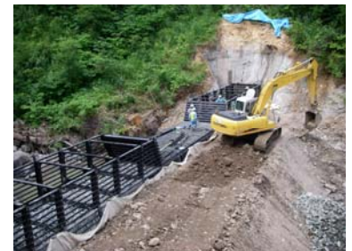
鋼製谷止工 工事状況(平成21年7月15日)
