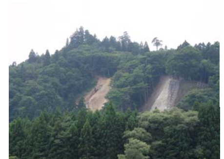
山腹工 工事状況 (平成21年7月15日)
