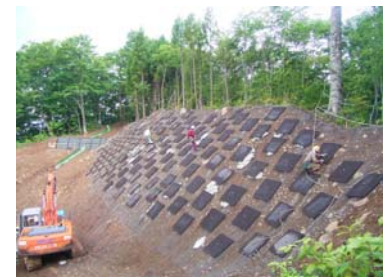
山腹工 工事状況(平成21年7月15日)
