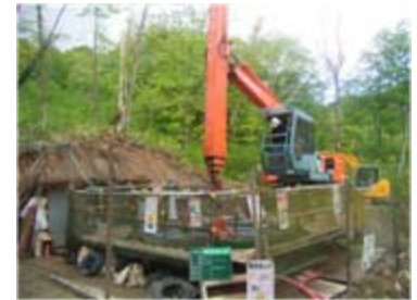
集水井工掘削状況(平成21年6月11日)
