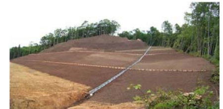
排土工工事状況(平成21年6月18日)
