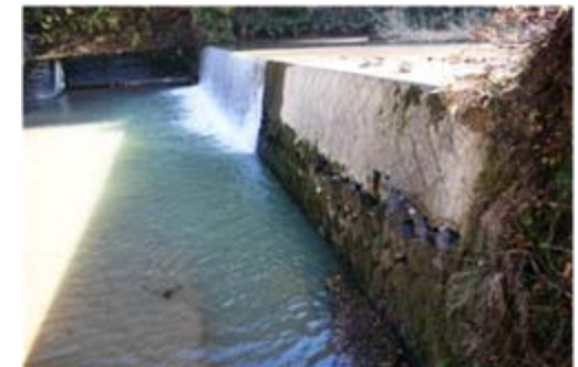
産女川治山ダム 施設被害状況
