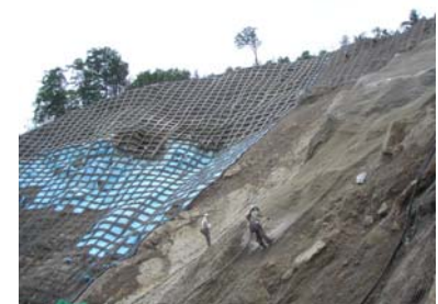
山腹工 工事状況(平成21年7月14日)
