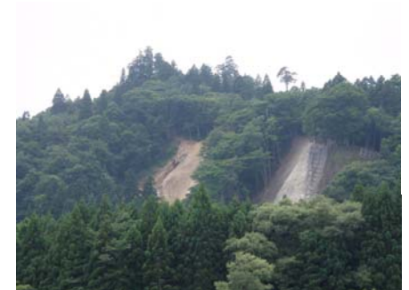
山腹工 工事状況 (平成21年7月15日)
