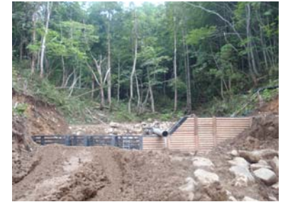
工事状況(平成21年7月15日)
