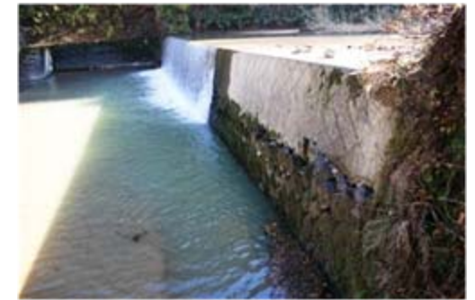
産女川治山ダム 施設被害状況
