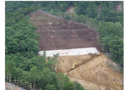
山腹工 工事状況(平成21年7月14日)
