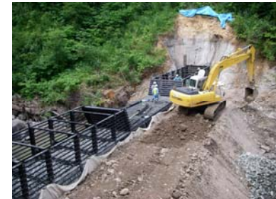
鋼製谷止工 工事状況(平成21年7月15日)
