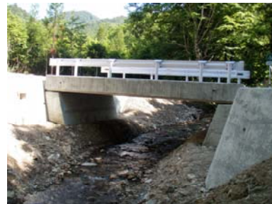
橋梁付替(平成21年6月25日)
