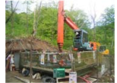
集水井工掘削状況(平成21年6月11日)
