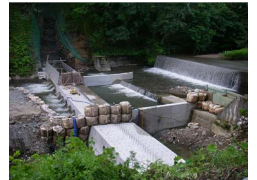
工事状況(平成21年7月15日)
