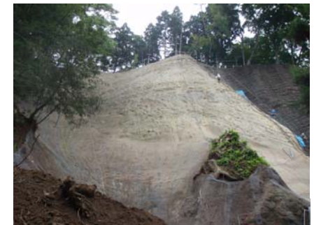
山腹工 工事状況 (平成21年7月14日)
