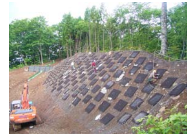
山腹工 工事状況(平成21年7月15日)
