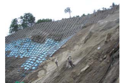
山腹工 工事状況(平成21年7月14日)
