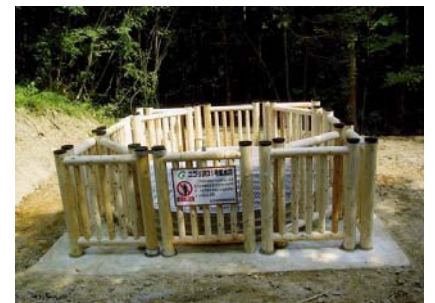
集水井完成状況(平成21年7月27日)
