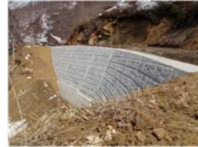
コンクリートブロック擁壁完了
