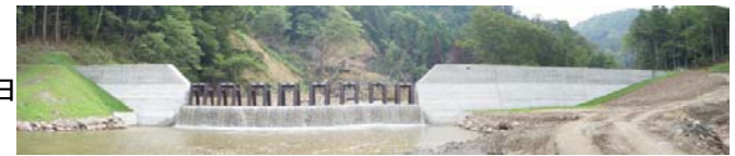
スリットダム 工事完成 (平成21年6月22日)
