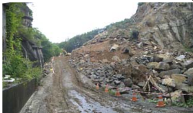
重機進入路作設状況(平成21年7月28日)
