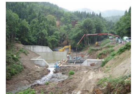
谷止工施工状況(平成21年7月29日)
