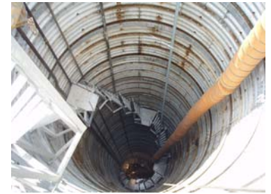
集水井工の施工状況 (平成21年6月25日)
