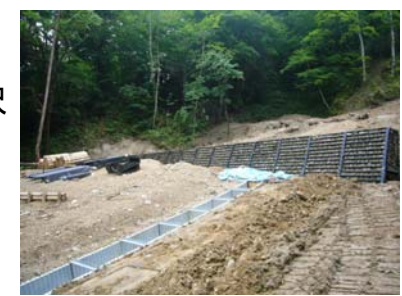
工事状況(平成21年7月27日)
