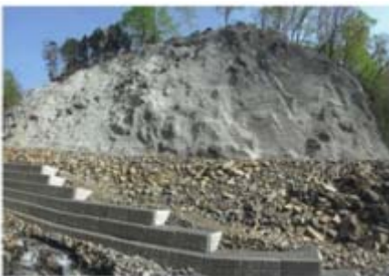
モルタル吹付等完了
