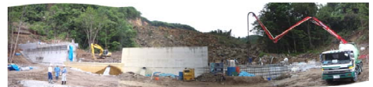
谷止工施工状況(平成21年7月9日)
