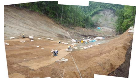
緑化工 工事状況 (平成21年7月24日)
