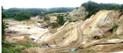
作業道作設状況 (平成21年7月22日)
