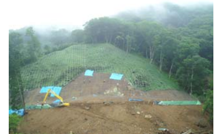
法砕工の施工状況(平成21年7月24日)
