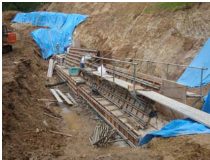
(3～11号)7号工事状況 (平成21年7月27日)
