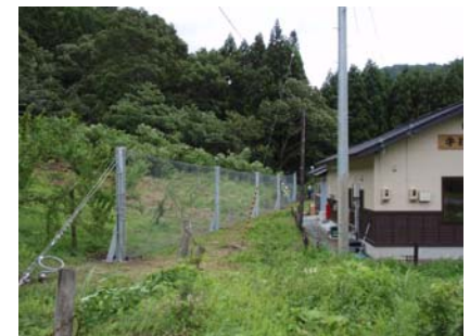
仮設工施工状況 (平成21年7月13日)
