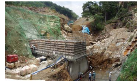
谷止工施工状況(平成21年7月15日)
