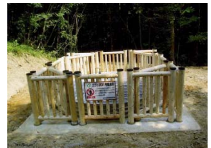
集水井完成状況(平成21年7月27日)
