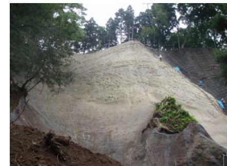
山腹工 工事状況 (平成21年7月14日)
