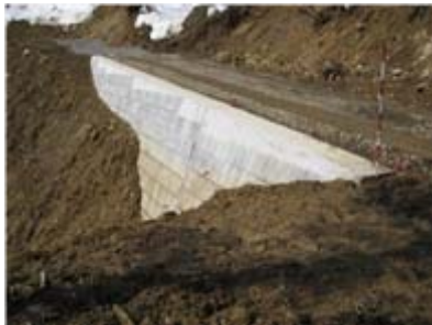
二段式擁壁完了
