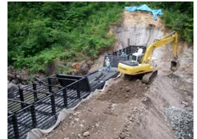
鋼製谷止工 工事状況(平成21年7月15日)
