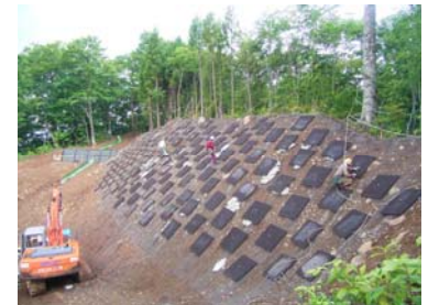
山腹工 工事状況(平成21年7月15日)
