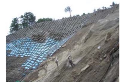
山腹工 工事状況(平成21年7月14日)
