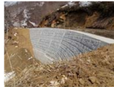
コンクリートブロック擁壁完了
