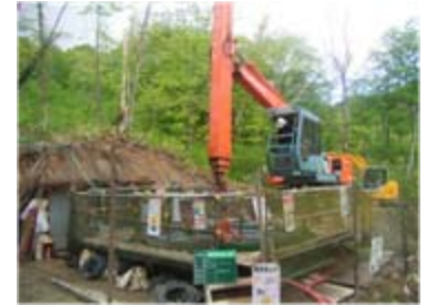
集水井工掘削状況(平成21年6月11日)
