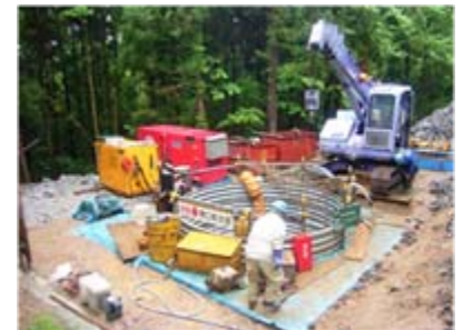
集水井工掘削状況(平成21年6月5日)
