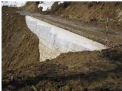
二段式擁壁完了
