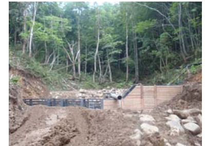
工事状況(平成21年7月15日)
