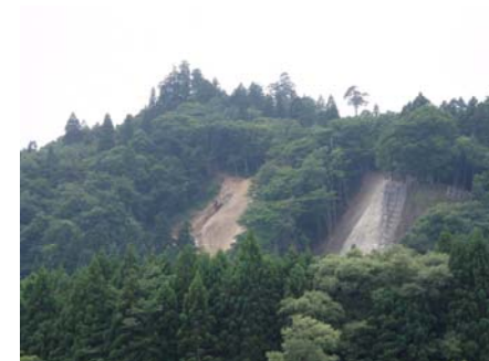
山腹工 工事状況 (平成21年7月15日)
