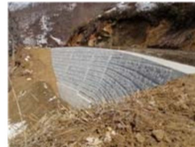
コンクリートブロック擁壁完了
