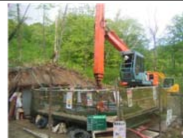
集水井工掘削状況(平成21年6月11日)
