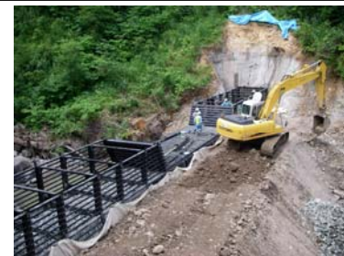
鋼製谷止工 工事状況(平成21年7月15日)
