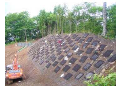
山腹工 工事状況(平成21年7月15日)
