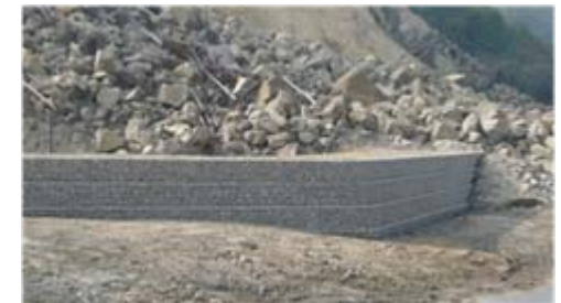
大型カゴ枠工 完了 (平成20年9月27日)
