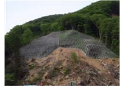
法砕工の施工状況(平成21年5月25日)
