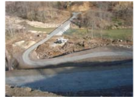
資材運搬路 工事完了 (平成20年11月15日)
