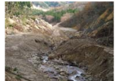
河道掘削工事完了(平成20年10月20日)
