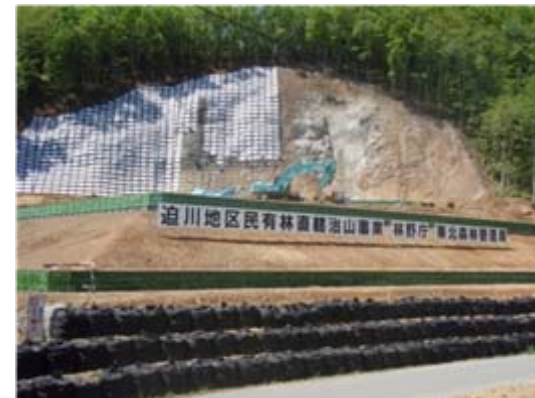
吹付枠工 工事状況 (平成21年5月19日)
