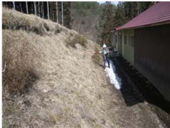
民家裏斜面の防災点検
