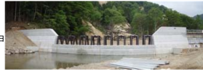
スリットダム 工事状況 (平成21年5月28日)
