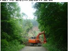
荒砥沢ダム上流部の復旧対策のほか、孤立化した集落(栗 原市耕英地区)への通行確保にも資する(市道)馬場駒の湯 線の崩土を除去(国有林に接する部分の崩土除去を6月22 日完了)
