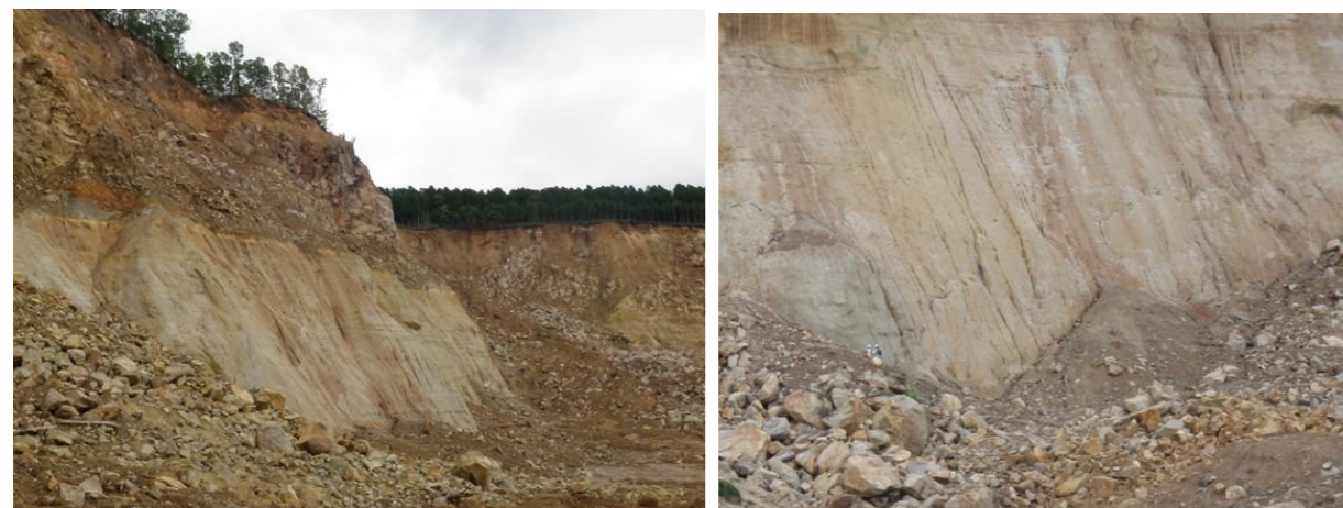
図 1.6 主滑落崖の軽石凝灰岩の傾斜(左)と開口亀裂(右)
