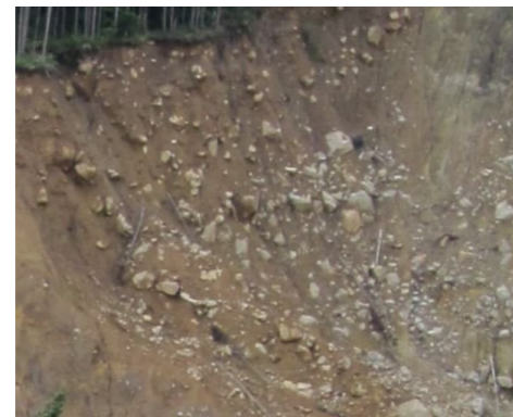
侵食により斜面から浮き出した石
