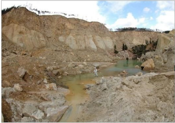
①第1リッジ付近の湛水池
