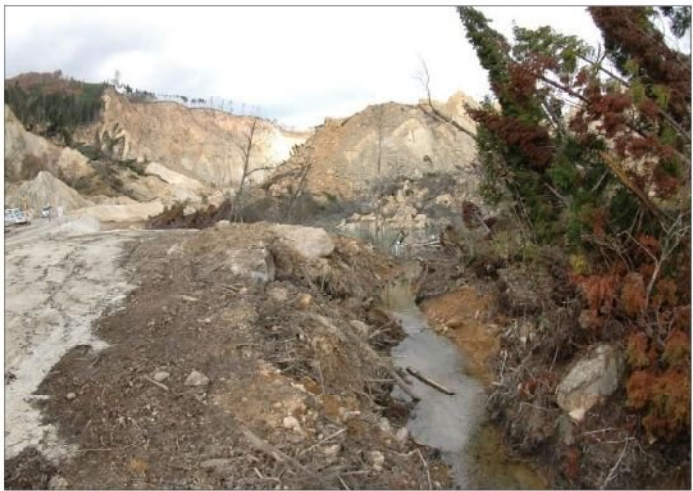
④湛水池からの流下状況 仮排水路
