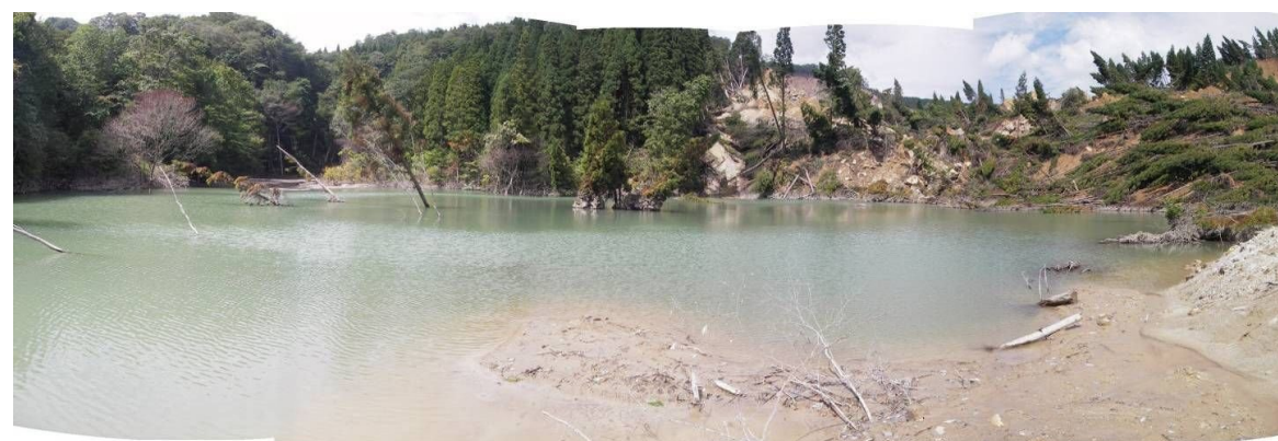
図2.1.5 一年経過後の湛水池における土砂堆積状況
