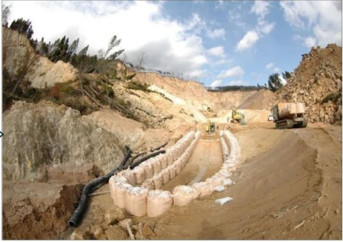
②仮排水路実施状況
