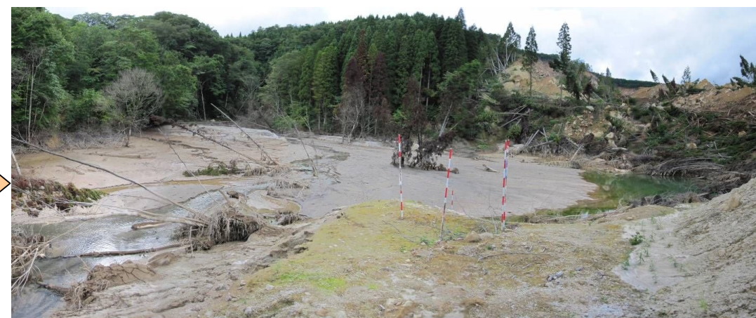
図2.1.5 一年経過後の湛水池における土砂堆積状況
