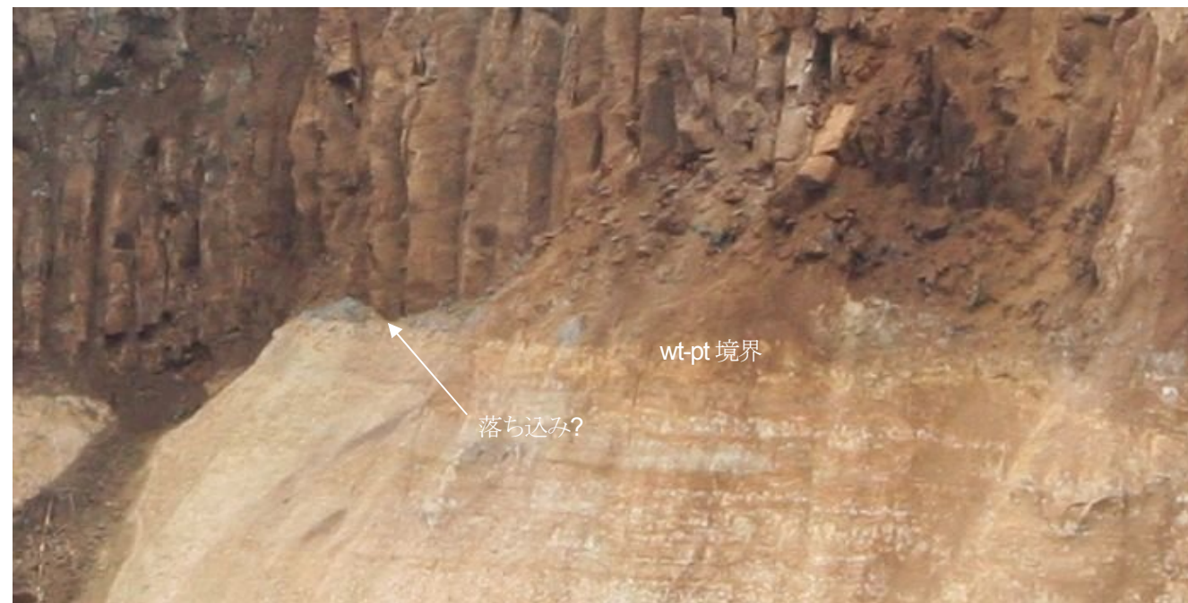
図 1.2.11 平成20年6月23日に撮影された溝状凹地部(図 1.2.9H 地点)
