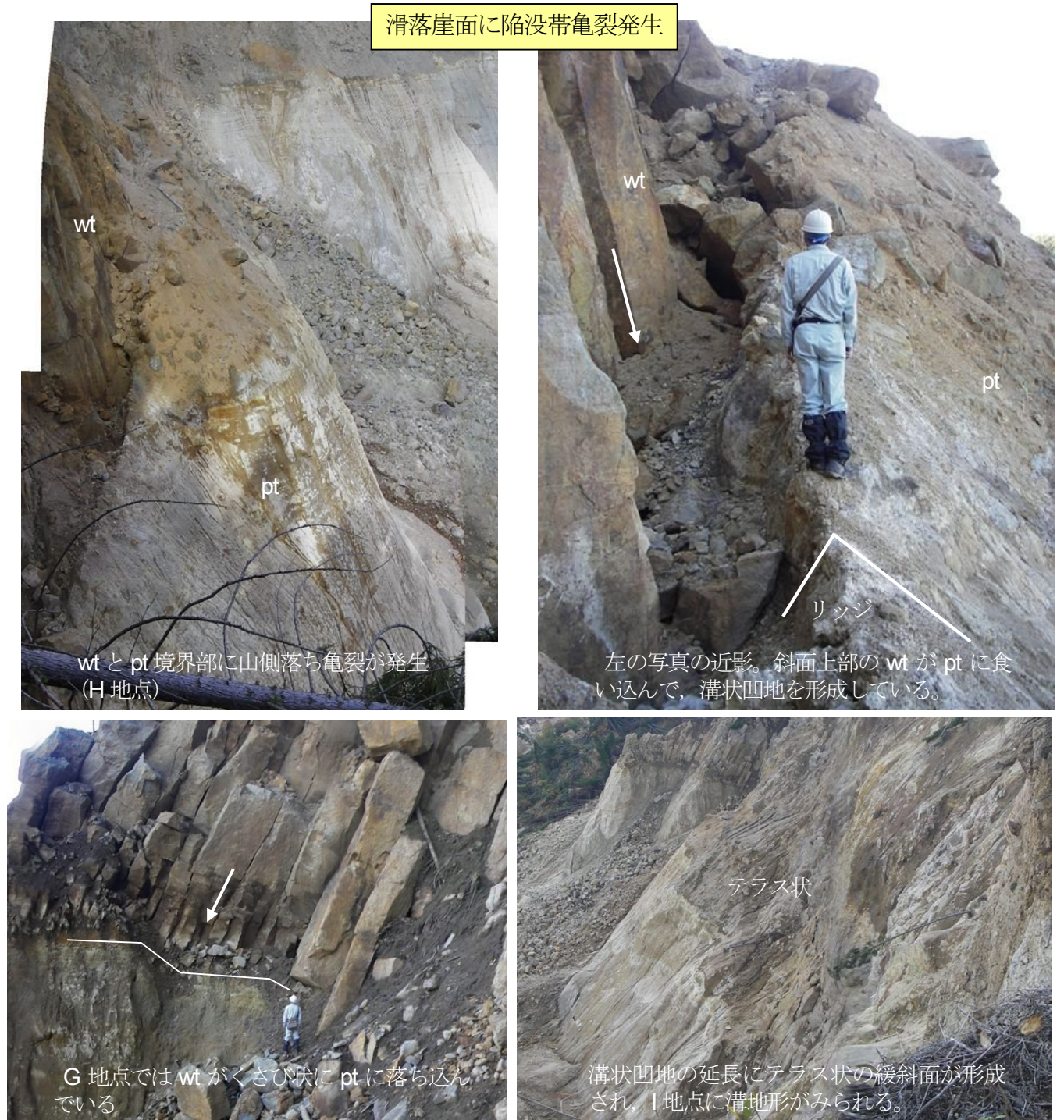
図 1.2.3 滑落崖中段に発生した陥没変形 (H・G 付近 : H.21.10.15 撮影)
