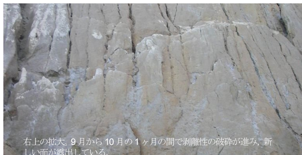
図 1.25 K 地点の軽石質凝灰岩の高角亀裂と亀裂の変化
