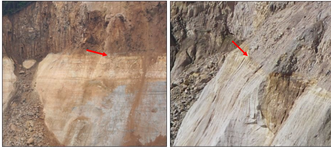
図 1.2.14 滑落崖右岸側側壁の状況 (左: 2008年6月23日 右: 2009年10月15日)
