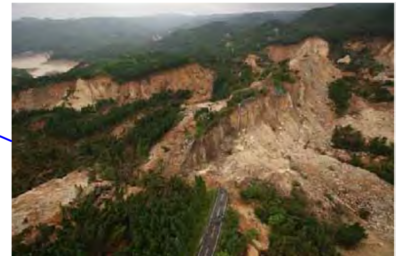
寸断された市道荒砥沢線
