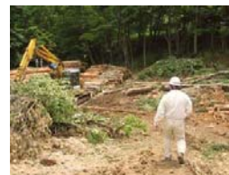
河道閉塞箇所の流木処理及び流木による二次災害を防ぐため、行者滝周辺の倒木処理を実施
