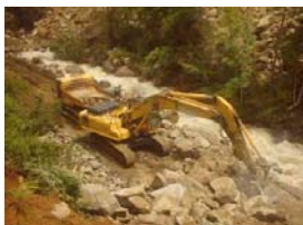
尿前沢 無人バックホーによる河道開削工事
