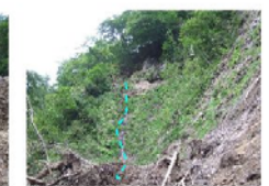
■ 連川左岸の山腹荒廃地自然復旧状況
