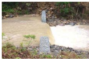
尿前川 応急復旧 カゴ枠工事
