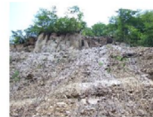
■ 連川左岸の荒廃地
