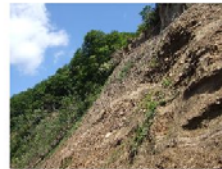
■ 連川左岸の荒廃地
