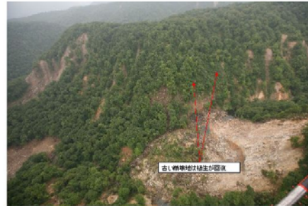
■一連川流域 根ノ沢左岸の荒廃地自然復旧状況
