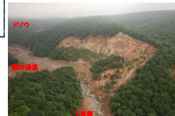
ドソウ沢を流下した土石流と河道閉塞(H20.8.5撮影)
