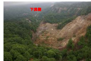
河原小屋沢支流 腰抜け荒廃状況
