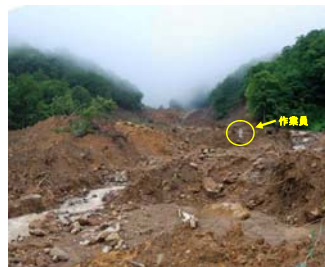
溪流荒廃状況
