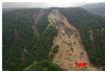
湯ノ倉地区河道閉塞状況
