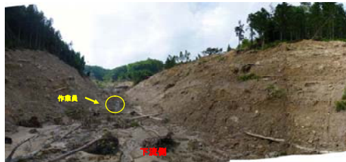
ヒアヒクラ沢 溪流荒廃状況
