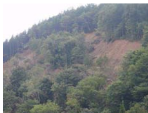
大寒沢 山腹崩壊(河道閉塞)
