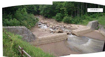
既設床固工による土砂流出防止状況
