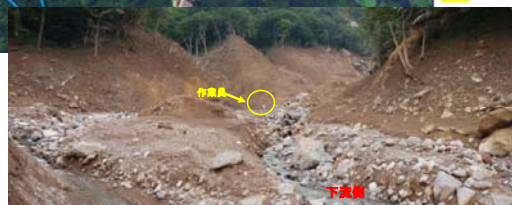
ドソウ沢荒廃状況(駒の湯温泉の上流側、谷止工計画位置)
