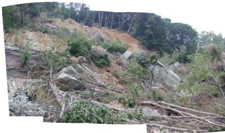
Bブロック崩壊状況
