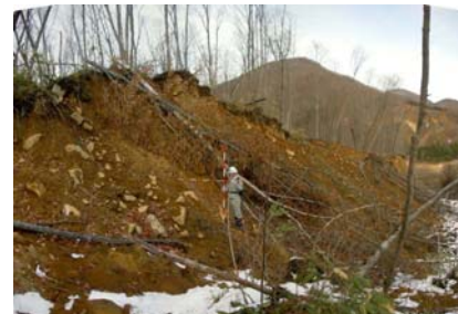
⑥主ブロック側の側壁(地質は安山岩転石を混じる土砂)
