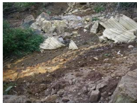
○ブロックすべり面(風化凝灰岩)
