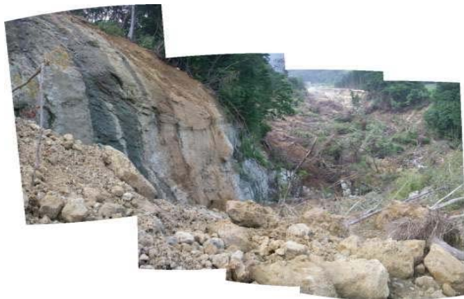
Bブロック左側部の崩壊状況
