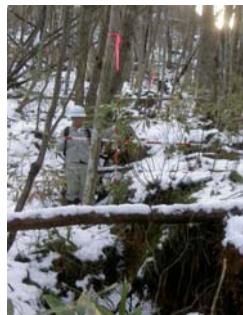
④主ブロック側に段差を伴い沈んだ亀裂
