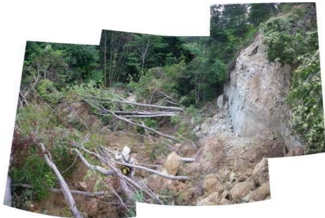
Bブロック右側部の崩壊(隣接する沢に向かう)
