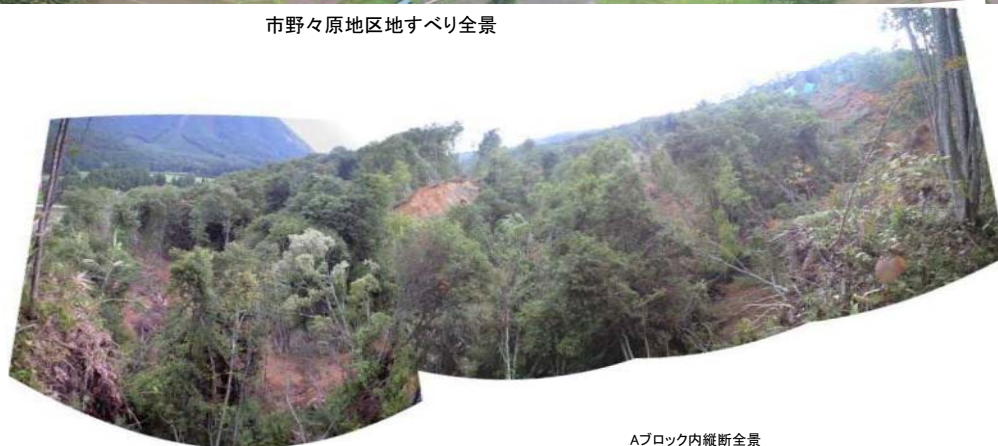
Aブロック内縦断全景
