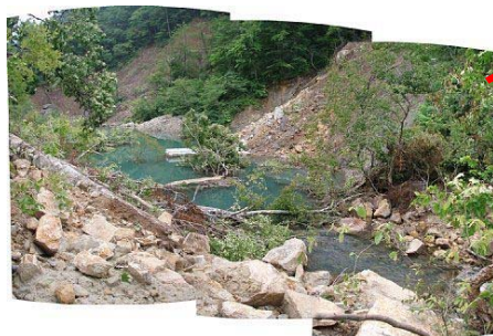
7月9日湛水状況(下流側から)
