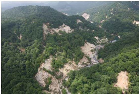
⑪尿前沢上流部 河道閉塞箇所の下流側荒廃状況
