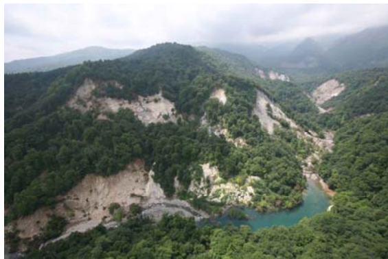
⑨尿前沢上流部河道閉塞状況
