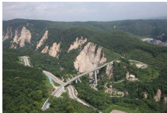
⑫尿前沢 国道橋梁
