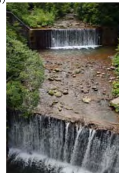
一ツ石橋上流 既設治山ダム2基
