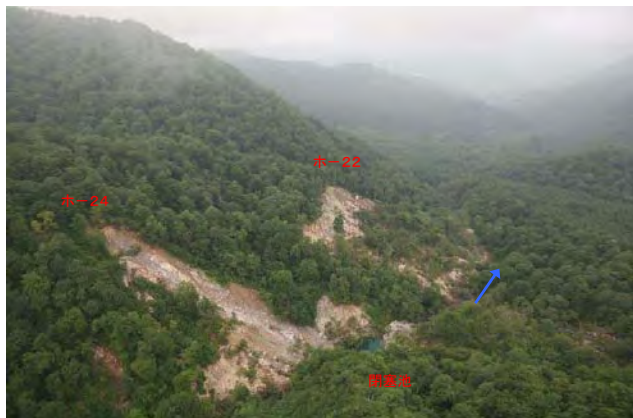
⑤一ツ石沢上流部の大崩壊群(上流側から)
