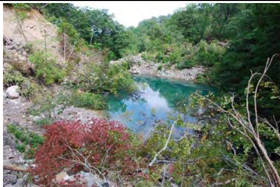
⑨河道閉塞による湛水池(上流側から)
