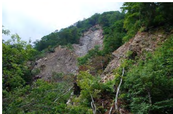
⑩ホー24の崩壊状況
