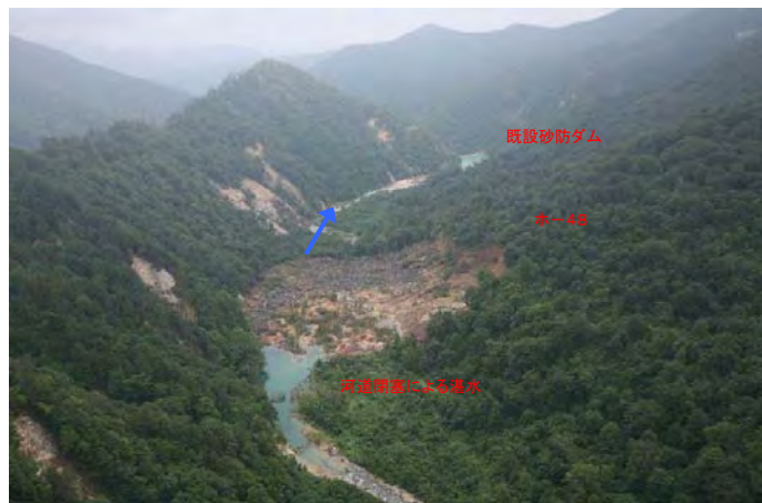
⑮磐井川本流右岸の地すべり(ホー48)と河道閉塞による湛水
