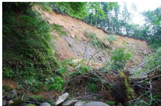
⑦ホ-19 国道342に近接(山腹工予定)
