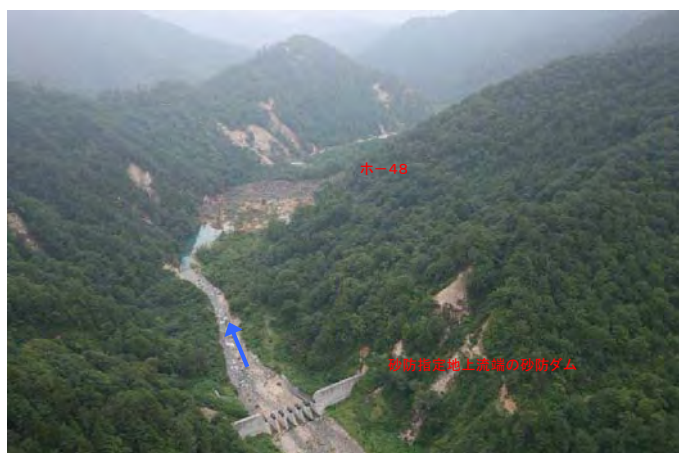
磐井川本流砂防指定地最上流のスリットダムと地すべり(ホー48)
