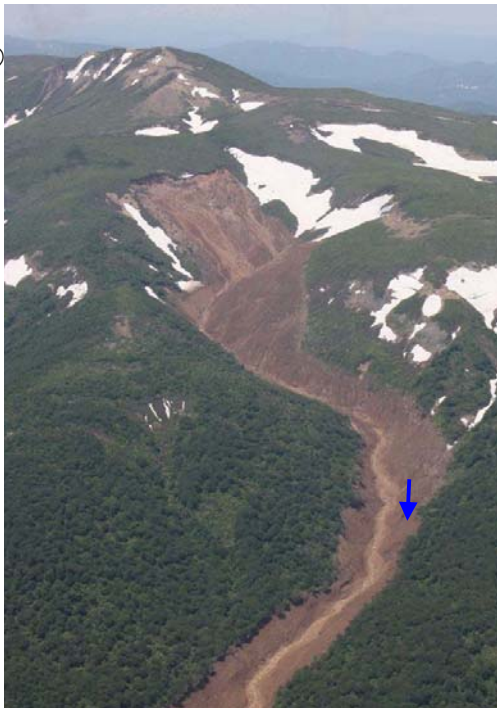
①ドゾウ沢源頭部の崩壊と土石流の流過痕跡
