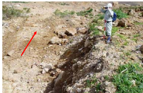
下部移動ブロックの側壁
