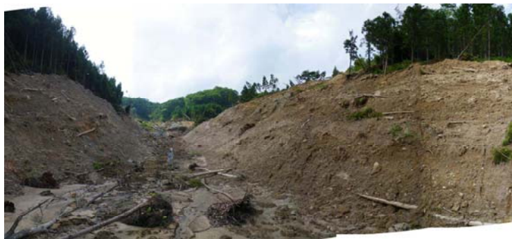
③山腹崩壊地下流側の溪床状況(谷止工計画位置)
