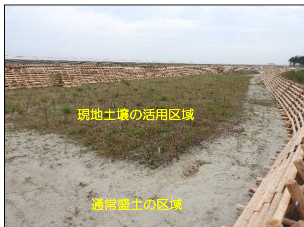
施工後、約1年半の状況
