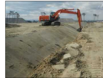
生育基盤盛土の造成
